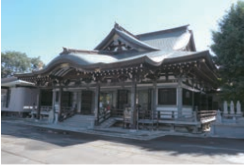
写真3 高野山寺本堂（S造、1986年）
