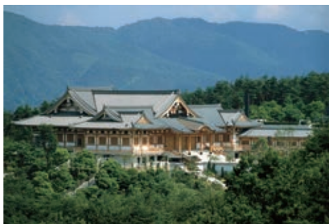
写真5 阿含宗総本山総本殿（SRC造、1990年）
