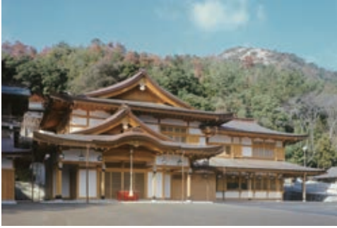
写真6 鹿嶋神社祈禱殿（木造、1992年）
