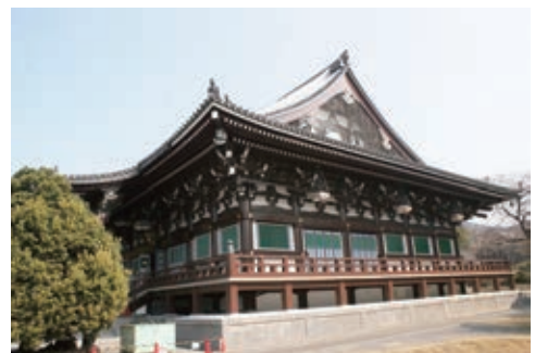
写真4 智積院金堂（RC造、1975年）
