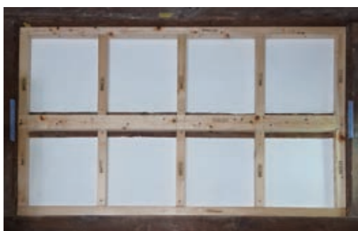
写真8 天守 1階 垂壁補強 (下地取付け完了)
