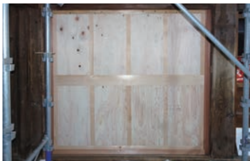
写真6 天守 1階 開口部補強 (構造用合板張り完了)
