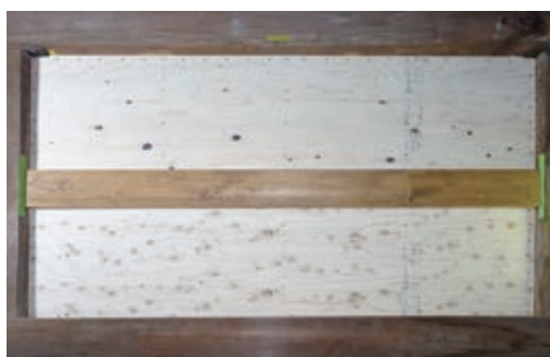
写真9 天守 1階 垂壁補強 (構造用合板張り完了)
