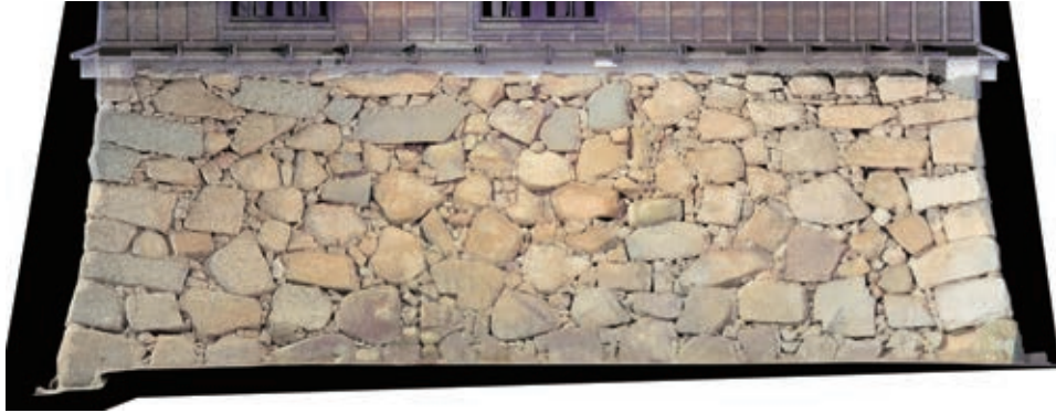
図8 石垣1 点群オルソ図 (石垣を真正面から見たような傾きのない画像に変換した図)
