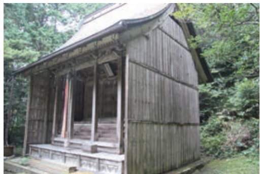
写真17 京都府北部（京丹後市）のしぶき除の事例
