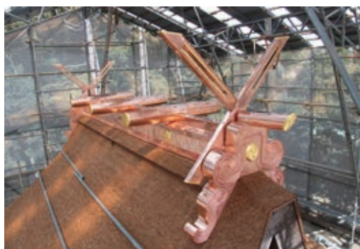
写真9 棟周りの銹金具および銅板
