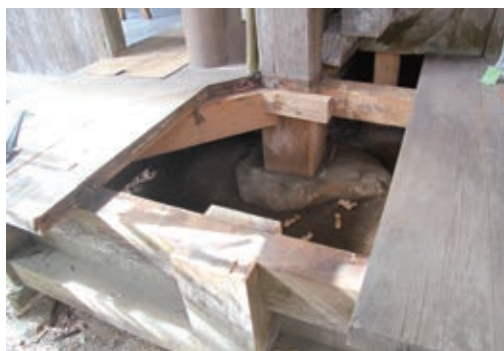
写真8 浜縁縁板の修理状況
