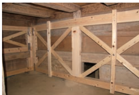
写真13 身舎床下 構造補強材取付
