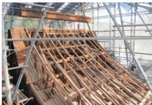
写真7 野垂木の復旧状況
