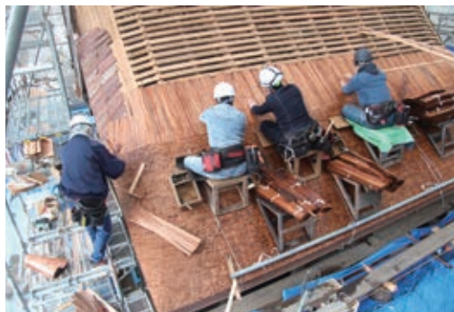
写真6 檜皮葺施工中 背面
