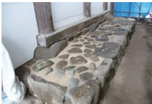
写真11 背面 玉石敷の目地漆喰塗
