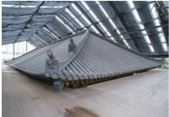
写真4 屋根瓦葺き替え・屋根裏構造補強工事
