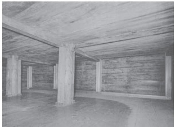
写真6 正倉の内部 ガラス戸棚が撤去された状態
