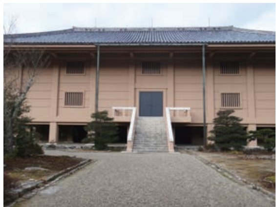
写真8 西宝庫(昭和37年竣工)
