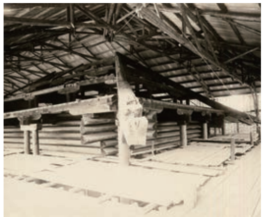
写真3 正倉解体修理の様子 旧屋根組
