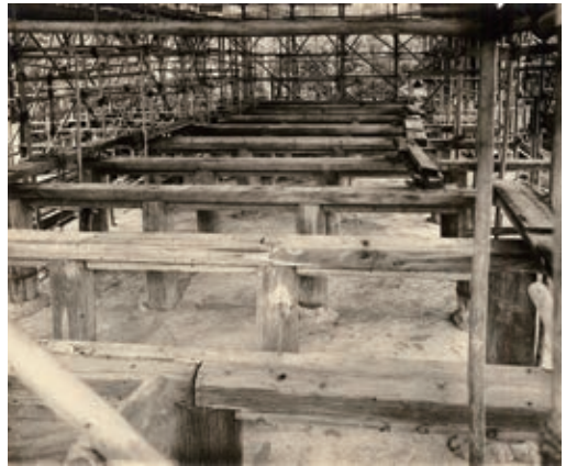
写真2 正倉解体修理の様子 組立時
