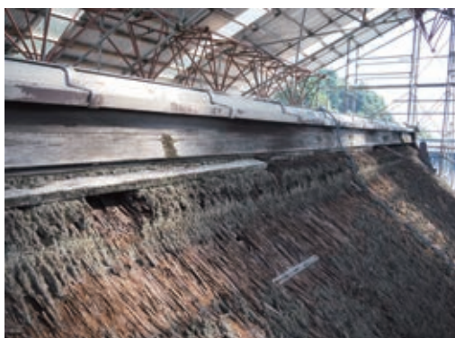
写真7 修理前 箱棟 アルミ板で包まれた屋根板
