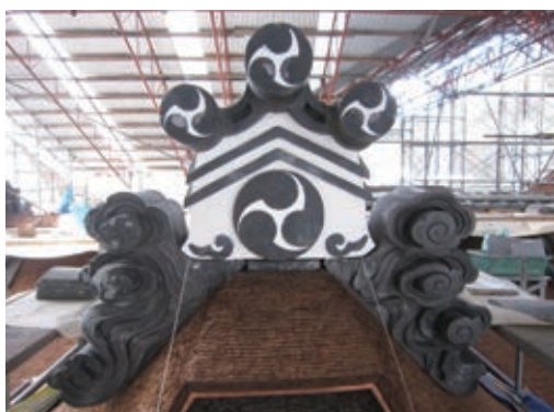
写真18 施工中 獅子口据え付け状況
