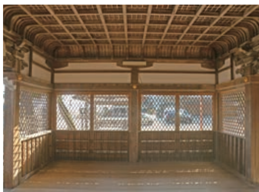
写真24 同前 漆喰塗仕上げ 正面小壁に荒壁パネルを設置
