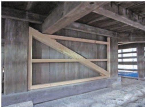
写真21 本殿床下外部 筋違設置 内部には貫が通っているため外部に設置
