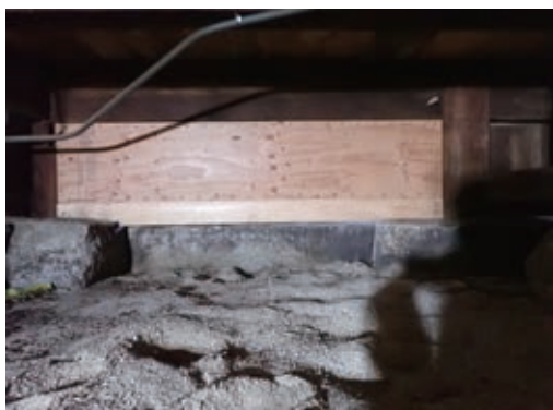
写真25 拝殿床下 構造用合板設置
