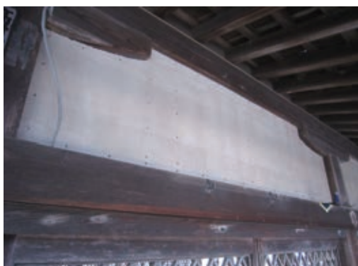
写真23 拝殿側面小壁 荒壁パネル設置
