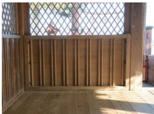
写真26 拝殿正面 取り外し可能な構造用合板設置
