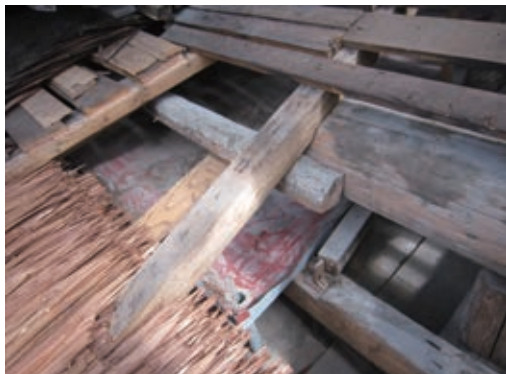
写真11 同前 受け皿の水は化粧裏板を配管で貫通させて排水
