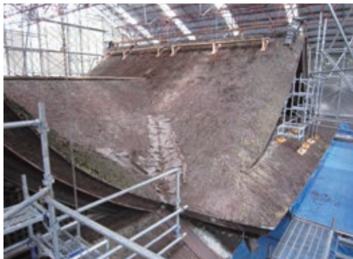
写真5 修理前 本殿と繋ぎ棟の取り付け部分 谷部分に金属板を差し込む
