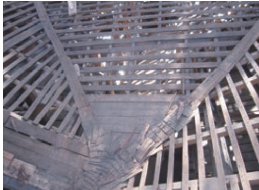
写真9 修理前 本殿と拝殿の取合い部 谷部下地に土居葺
