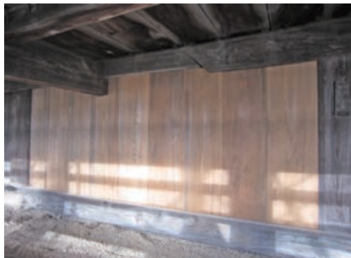
写真22 同前 縦板張仕上 既存板壁と同様に縦板張とし、筋違を隠す
