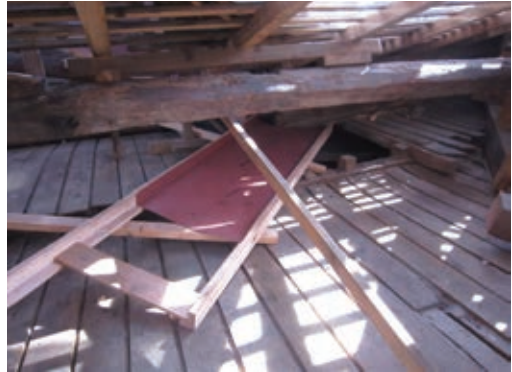
写真10 同前 小屋裏に銅製受け皿を設置
