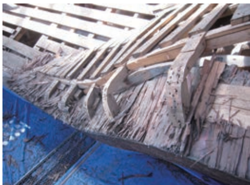
写真15 修理前 拝殿 葺甲下地、野木舞状の部材を葺甲上に掛ける
