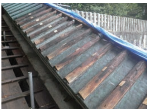
写真15 瓦棒、銅瓦葺の葺き直し（築地塀）
