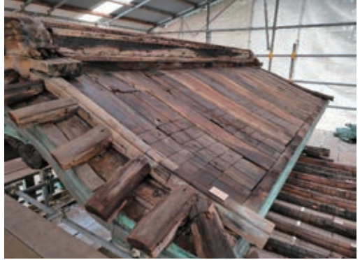
写真6 下地瓦棒の解体（唐門）
