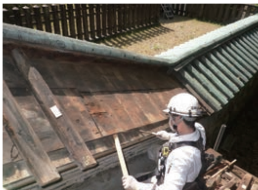
写真11 銅瓦葺解体（築地塀）
