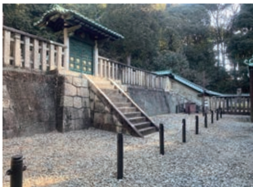
写真20 唐門前 立入防止柵
