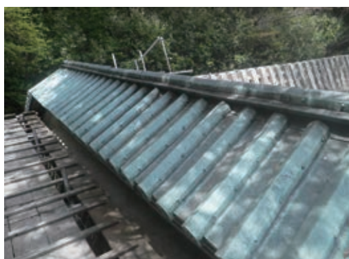
写真16 銅瓦葺屋根葺き直し完了（築地塀）
