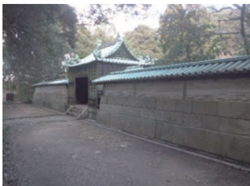
写真25 竜の門及び築地塀全景（修理後）
