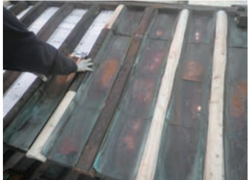
写真8 瓦棒間の捨銅板葺き直し（唐門）
