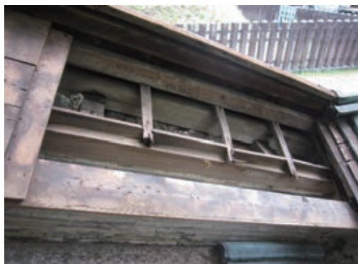
写真12 二重野地板の解体（築地塀）
