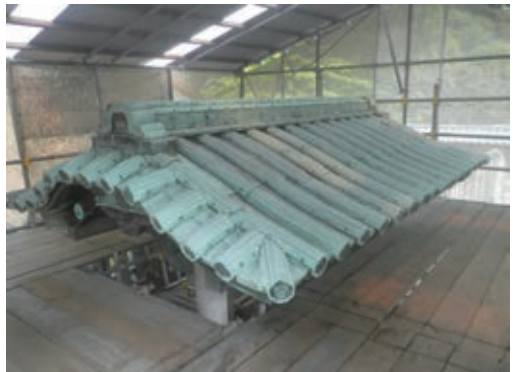
写真10 銅瓦葺屋根葺き直し完了（唐門）
