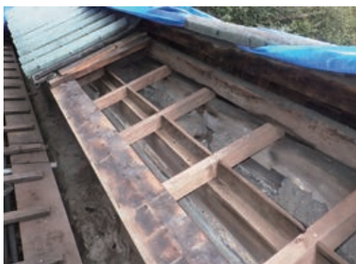
写真13 垂木の取替（築地塀）
