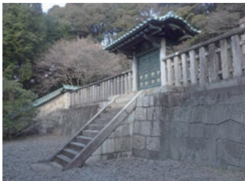
写真24 唐門全景（修理後）
