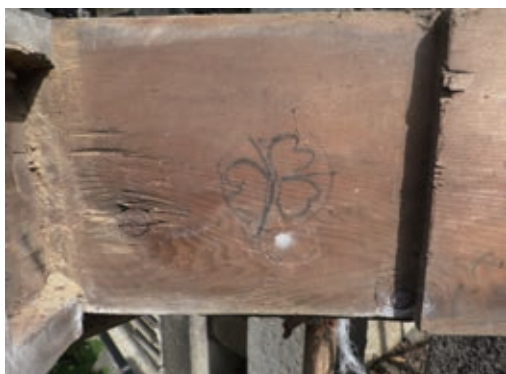
写真22 築地塀桁継手の合番付（葵紋）
