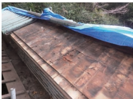
写真14 野地板の葺き直し（築地塀）
