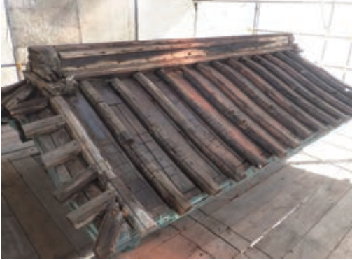
写真5 銅瓦葺の全面解体（唐門）
