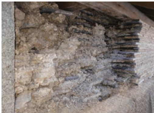
写真17 築地塀熨斗瓦積解体状況
