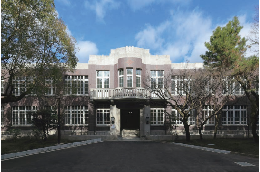
口絵3 京都大学(中央)総合研究15号館(旧建築学教室本館) 改修後 外観南面
