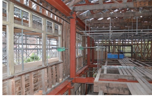
写真10 鉄骨フレーム
