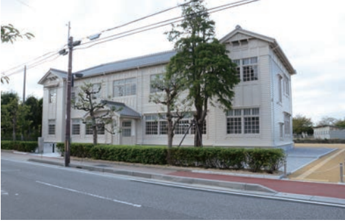
写真23 竣工正面（北面）
