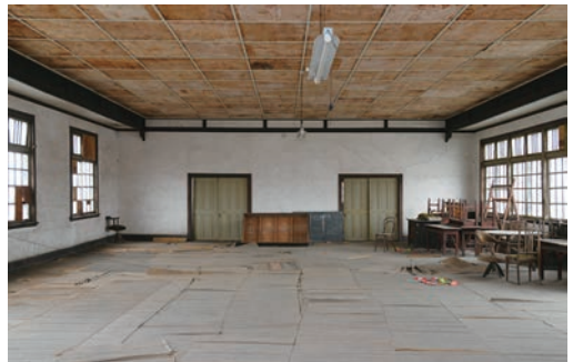
写真4 修理前ホール（西側を見る）
