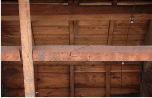
写真19 天井野縁下面 木摺り板痕跡
