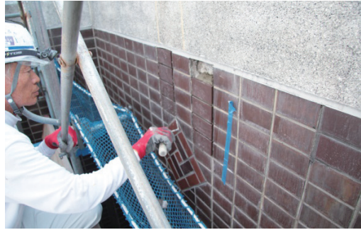
図4 外壁補修（タイル復旧状況）
