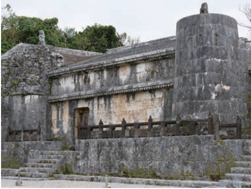
写真3 巖頭・東室・円塔、基壇
