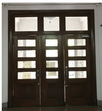
図9 正面玄関出入口扉
