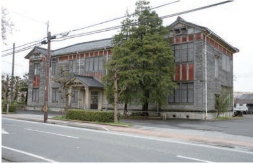
写真1 修理前正面（北面）
