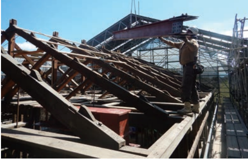
写真9 鉄骨搬入状況
