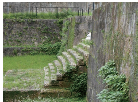
写真8 円覚寺にみる石造技術 石階の曲線（視覚補正）
