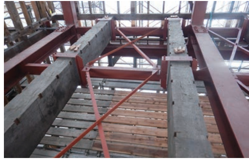
写真12 2階床下水平ブレース
