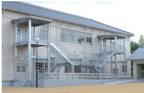
写真13 新設屋外階段
