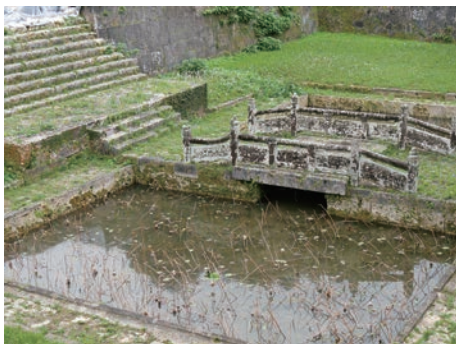
写真7 円覚寺にみる石造美 放生橋（重要文化財、1498年）と石階
