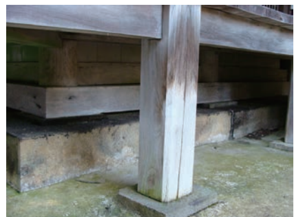
写真4-5 一つの束に見られた藻類(基部)、白化(中間)、カビ汚染(上部)
