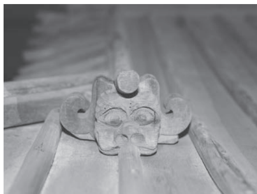
図13 宮殿、修理後 降り棟鬼板、再取付け
