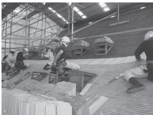
図8 身舎屋根、平葺き施工状況
