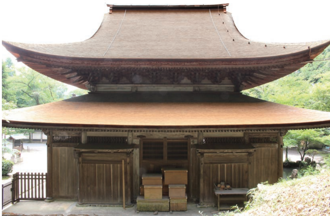
口絵10 定光寺本堂 竣工 背面
