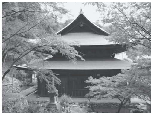
図15 施工完了、西面外観
