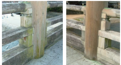
写真4-4 三条大橋の南側高欄(左)と北側高欄(右)
