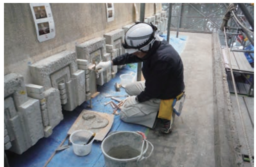
擬石飾りAタイプ 欠損部を左官補修中
