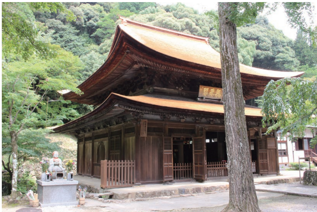
口絵9 定光寺本堂 竣工 正側面
