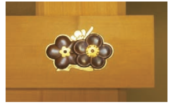
図8 参禅ノ間長押釘隠金物
