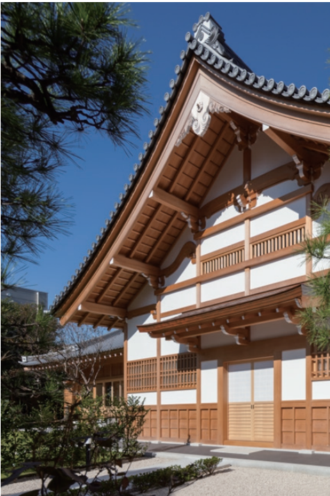
图3 玄関 正面部分
