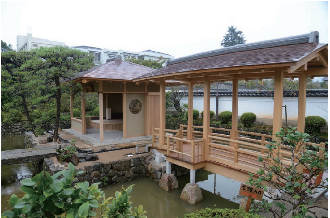
口絵4 天池堂・渡り廊下 北西より見る
