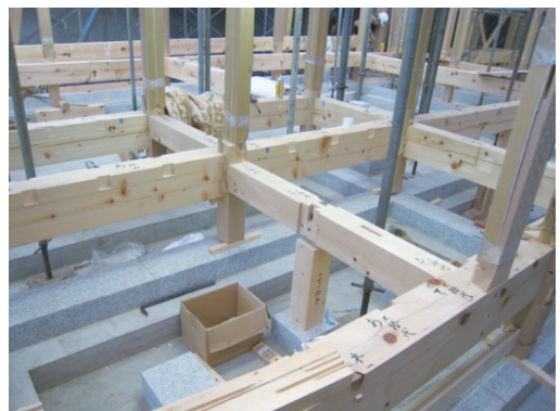
図15 茶室棟足固取付状況
