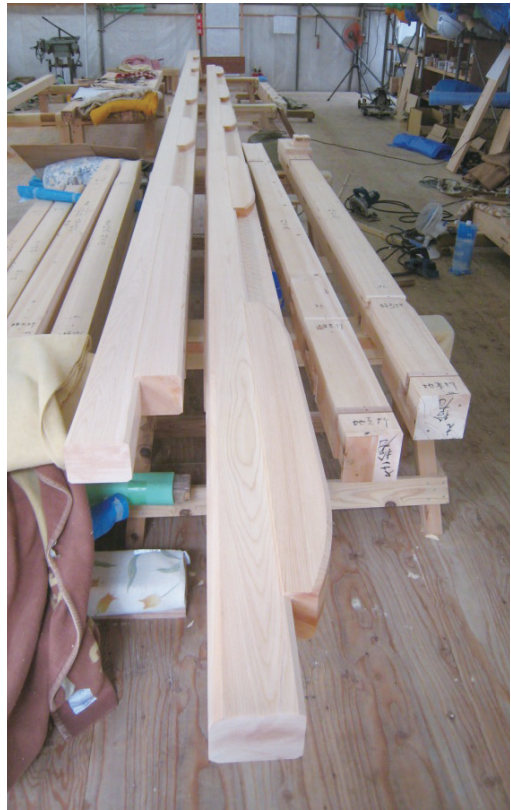
図20 茶室棟軒桁の加工状況
