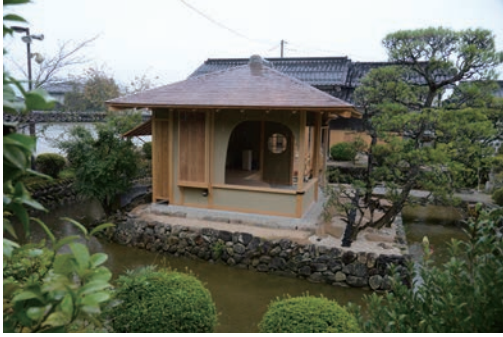
図6 天池堂（東より見る）
