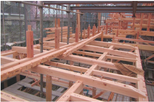
図18 茶室棟小屋組の状況
