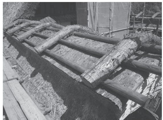
図5 棟廻り葺き替え完了
