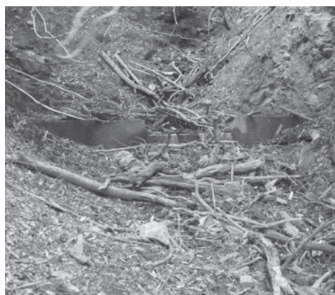
図12 既存取水口堰堤 土砂により埋没している
