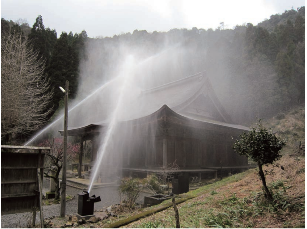
口絵3 羽賀寺本堂 放水（放水銃3基）
