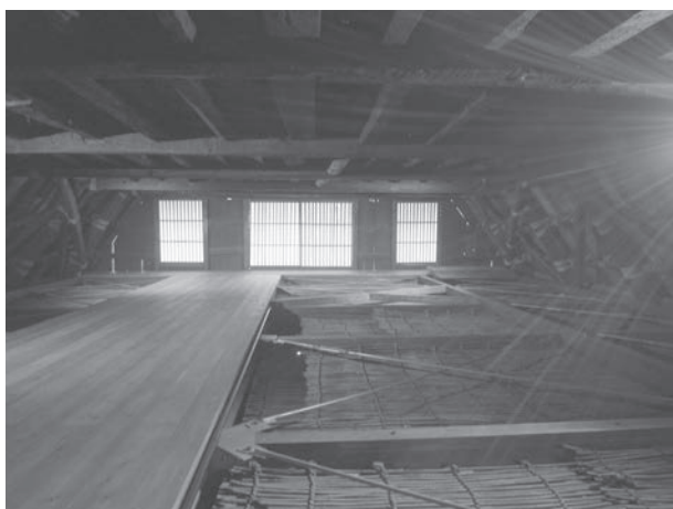
図13 水平ブレース、床板張り完了
