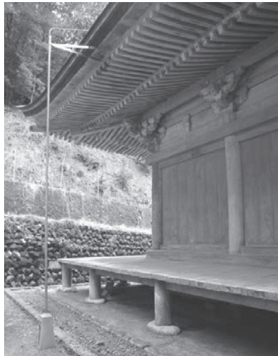
図36 避雷設備 立下げ保護管（竣工）
