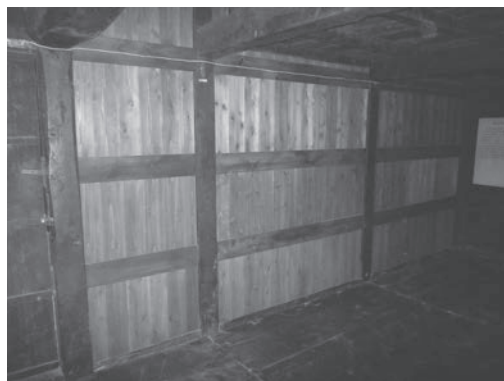
図10 複合鋼板パネル、化粧板張完了
