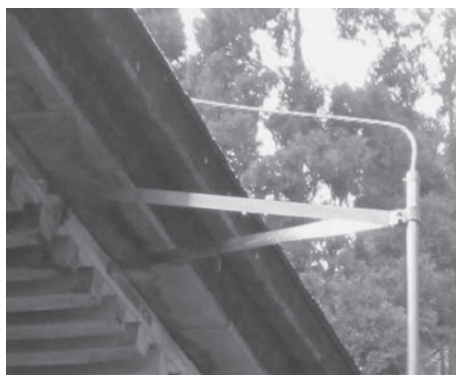
図34 保護管取付（改修）
