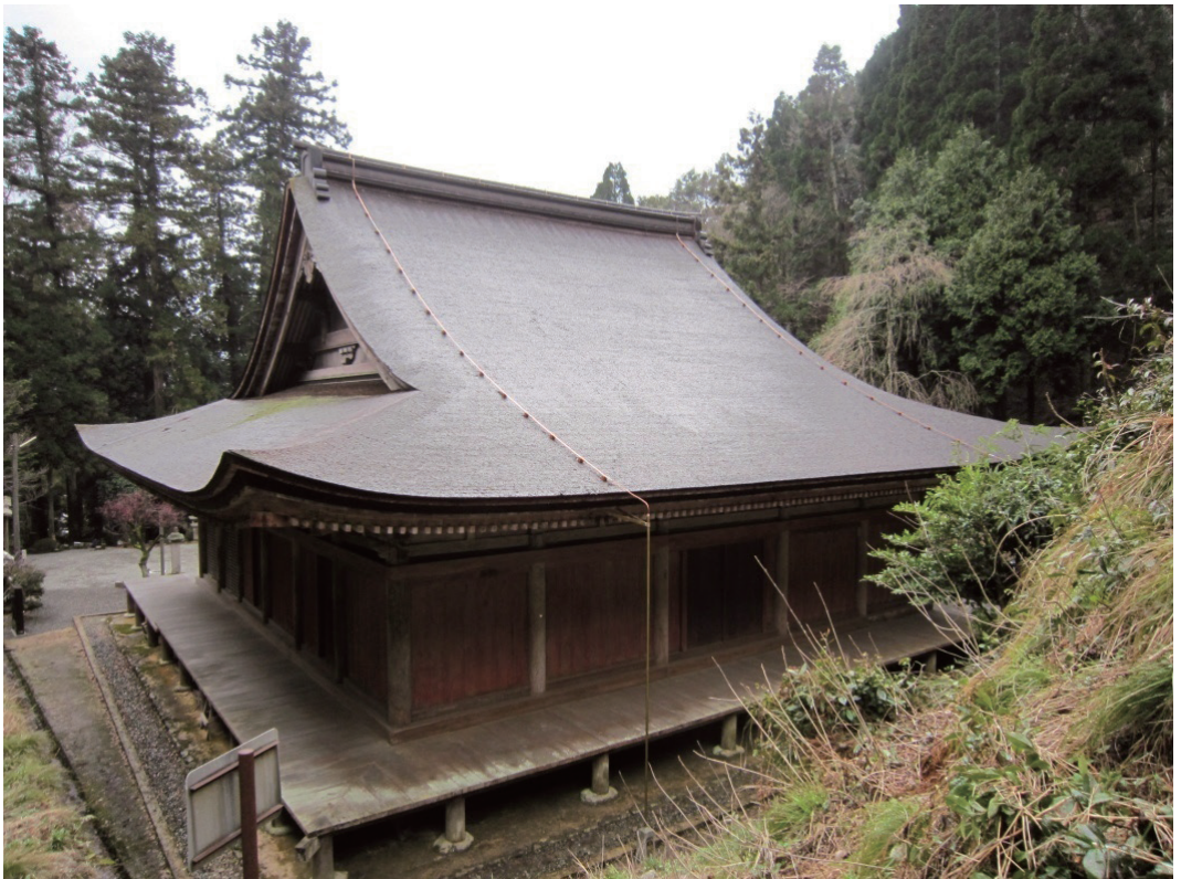
口絵4 羽賀寺本堂 避雷設備（竣工）
