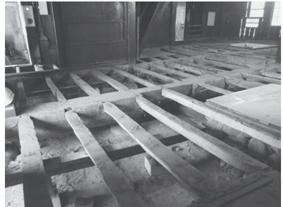
図4 床板解体完了
