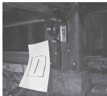
図18 柱と大引の仕口に耐震リングを取り付けた状態
