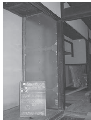
図13 複合鋼板耐震壁取付状況
