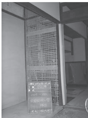
図12 土壁の解体状況（小舞下地）
