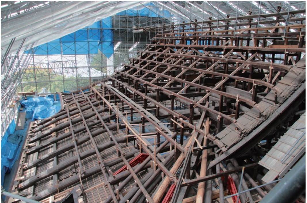
口絵4 妙覺寺祖師堂 修理中小屋組全景
