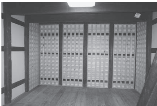
図20 一階面格子壁設置状況
