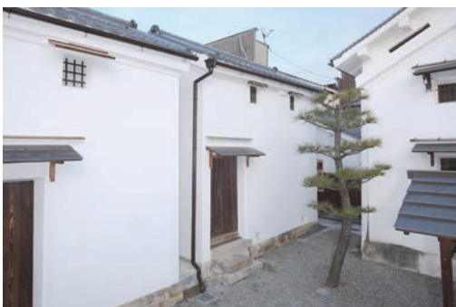
図27 土蔵1 竣工 正面 (写真中央)
