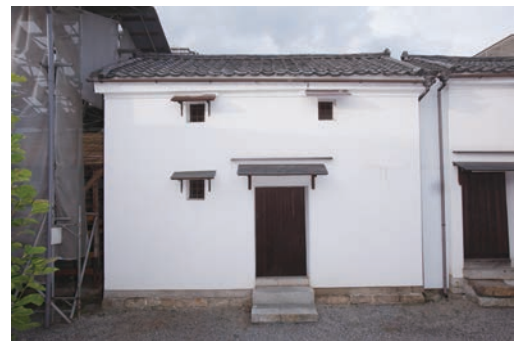
図10 土蔵3 修理前 正面
