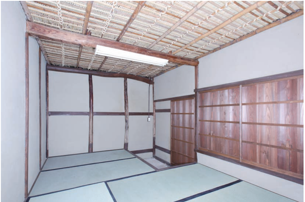
口絵4 草津宿本陣長屋 六畳半間（西側より東側を見る）
