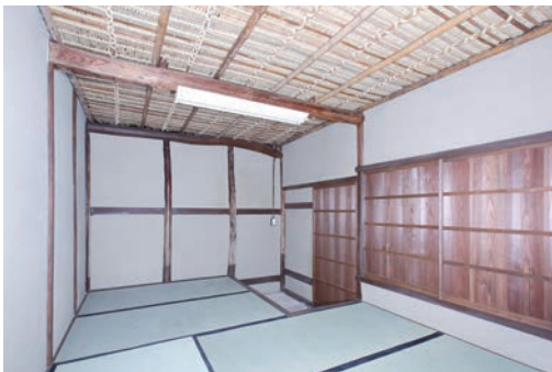
図25 長屋 竣工 六畳半間 (西側から東側を見る)
