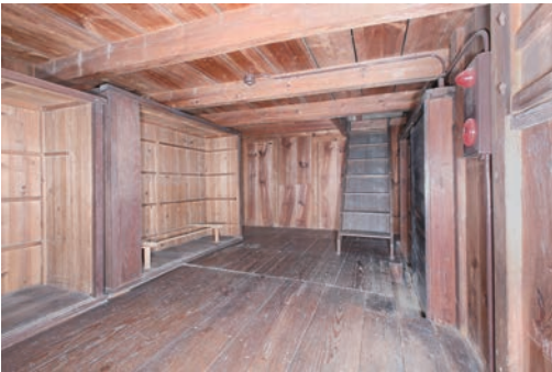
図31 土蔵3 竣工 1階 (西側から東側を見る)
