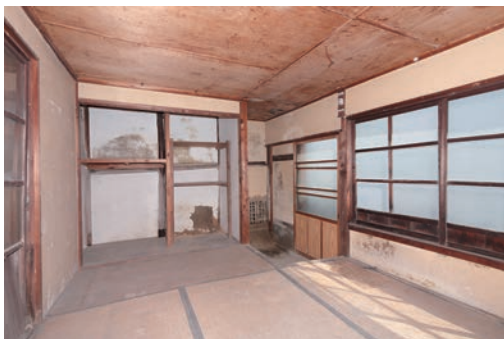
図5 長屋 修理前 六畳半間 (西側から東側を見る)
