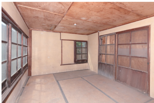
図11 長屋 修理前 六畳半間 （東側から西側を見る）
