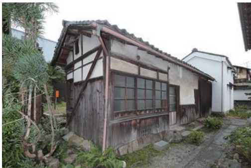
図3 長屋 修理前 正面
