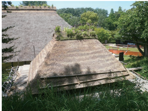
図2 芝棟（棟仕舞い）
