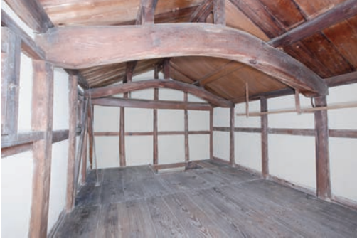
図29 土蔵1 竣工 2階 (東側から西側を見る)
