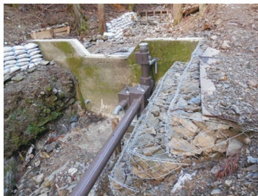
写真8 堰堤導水管
