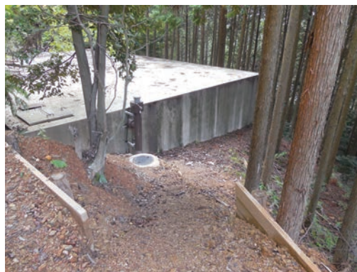
写真10 貯水槽空気弁
