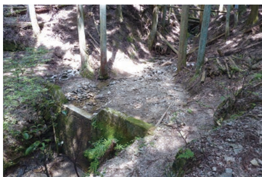
写真1 工事前の堰堤(下流側より)
