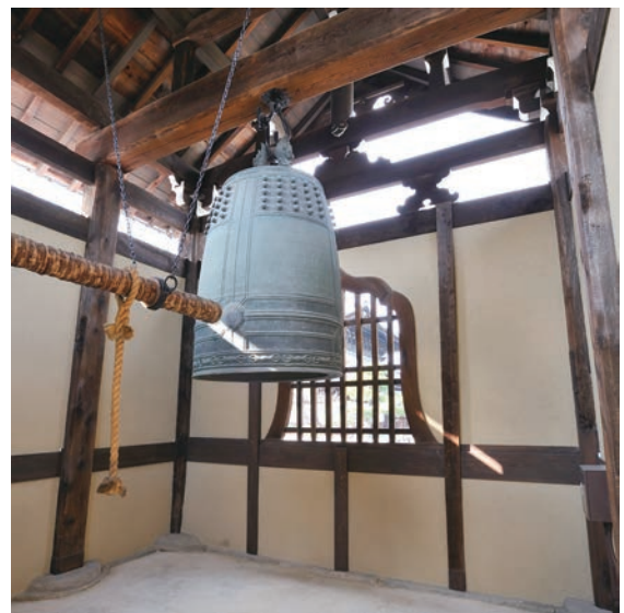
図19 大鐘楼内部（北東隅より）
