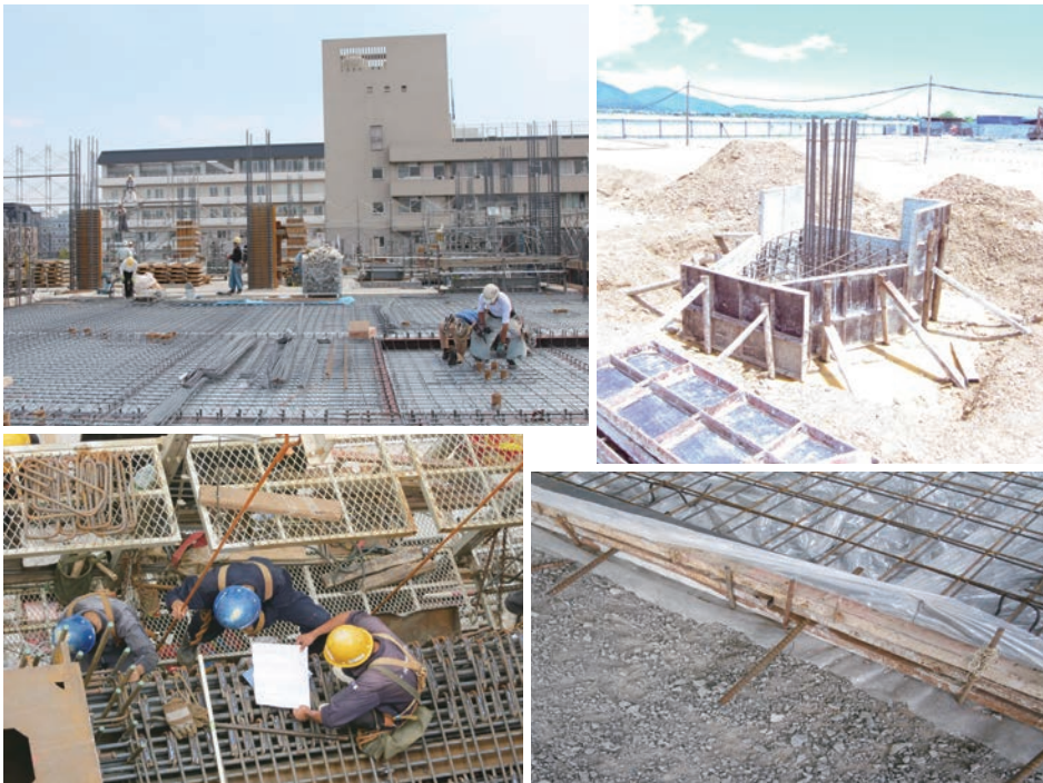
スライド2 鉄筋組立4景
