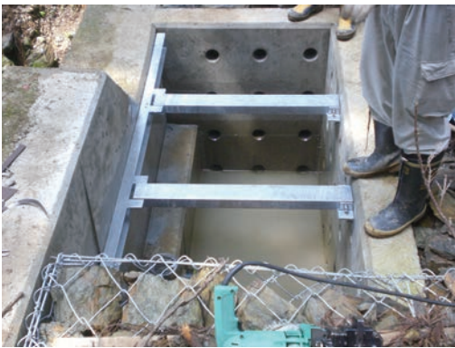
写真5 ピット通水孔
