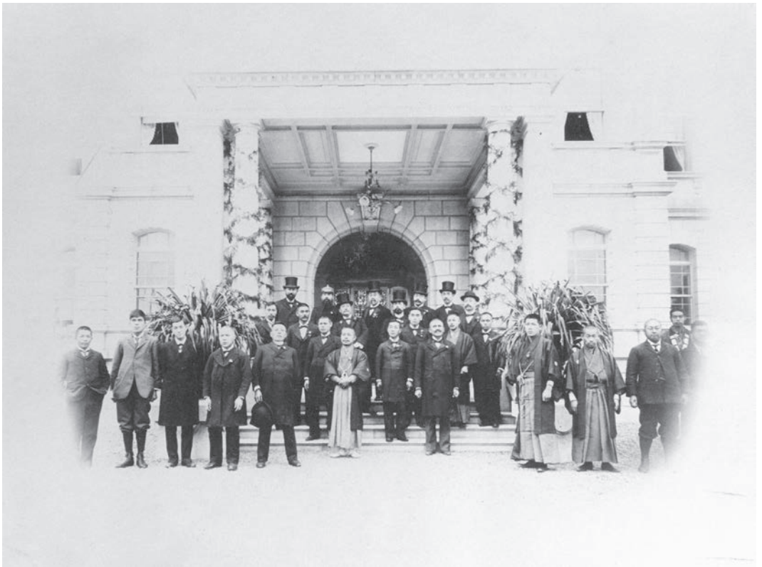
口絵2 京都府庁旧本館 竣工当時の記念写真 右側の袴姿が棟梁三上吉兵衛（古写真）
