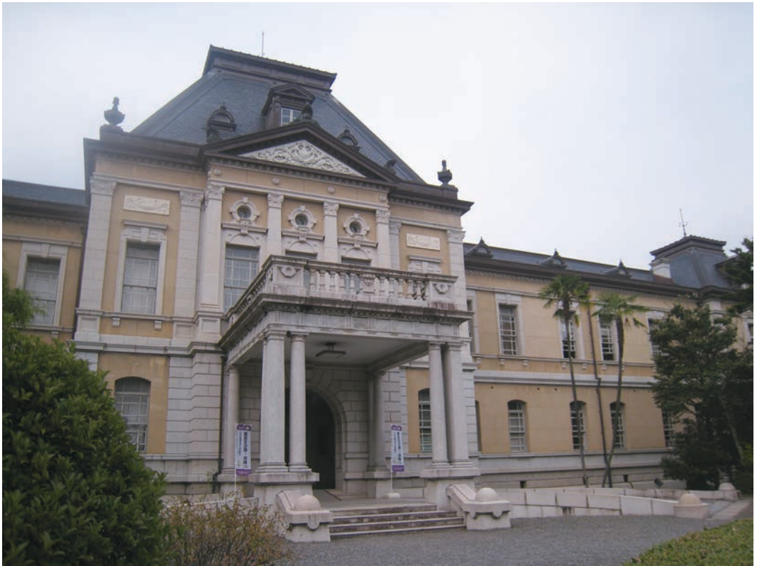
口絵3 京都府庁旧本館 現在の正面玄関周辺
