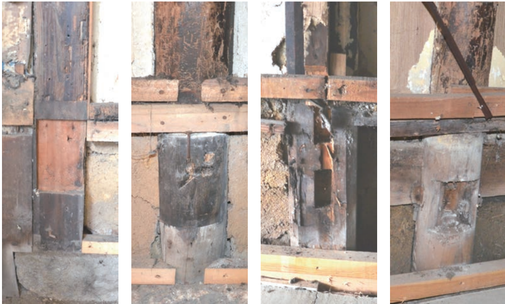
図5 「は」通柱下部 左から「二」通、「四」通、「七」通、「八」通
