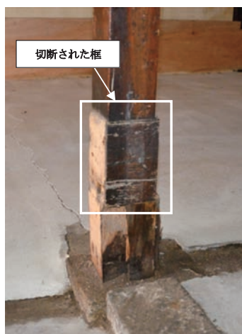
図6 「ろ」通「七」柱下部
