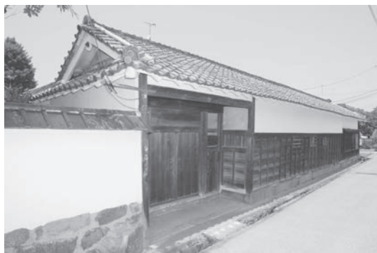
図3 修理前 正面（東面）
