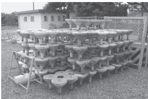
図8 コマ型コンクリートブロック搬入
