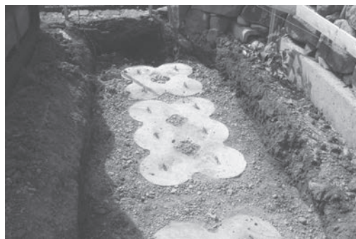
図9 コマ型コンクリートブロック敷設
