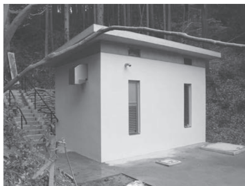
写真-12 取水ポンプ室（改修後）
