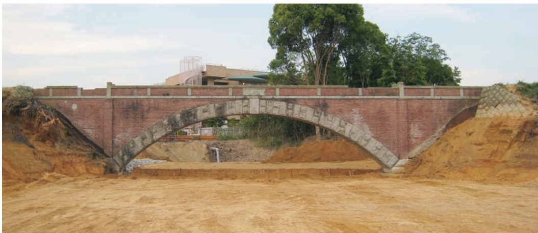
写真-4 鋼製支保工設置前の状況（下流側）
