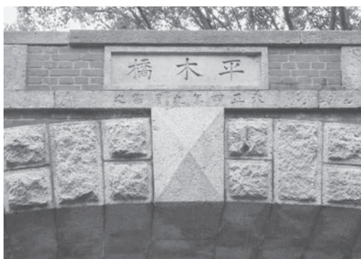
写真-2 上流側の額石と地覆石の陰刻
