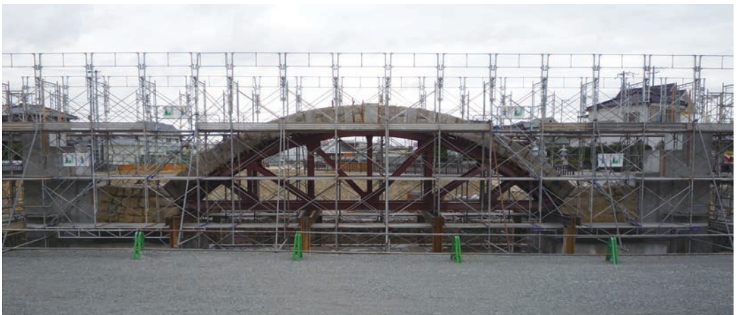
写真－10 要石・輪石設置完了（下流側）
