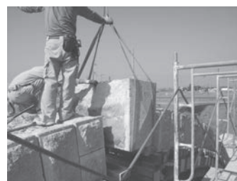
写真-8 要石取外し状況
