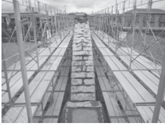
写真-12 輪石設置完了
