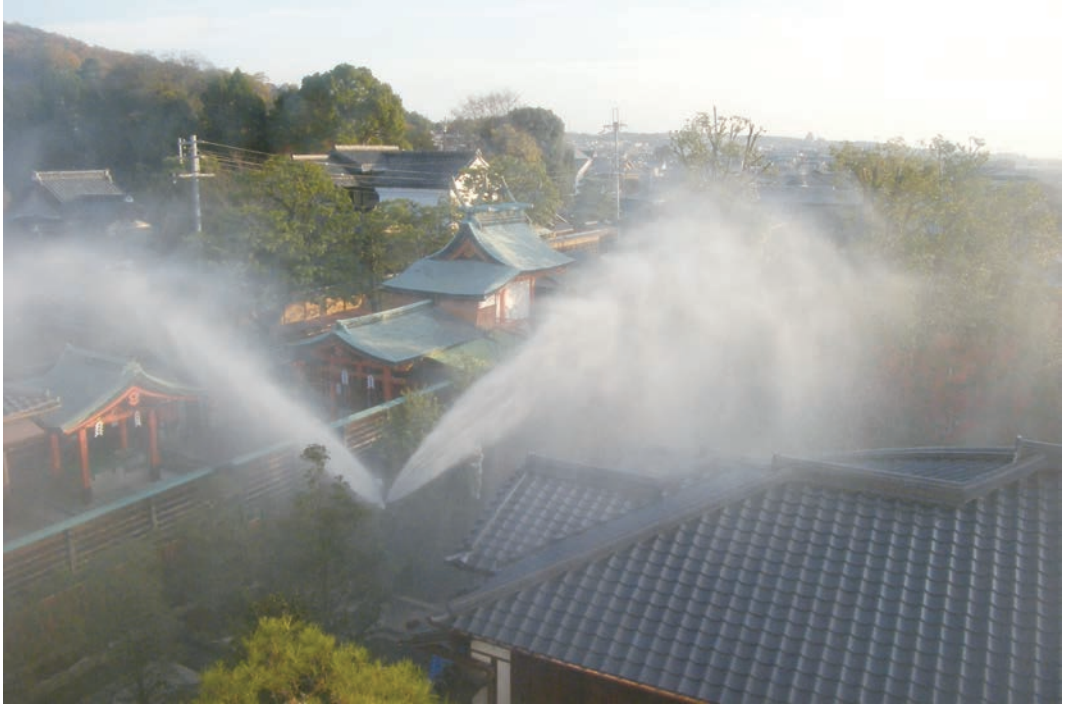
口絵5 史跡荷田春満旧宅 放水（ノズルが2連式になっており書院と表門に放水する）
