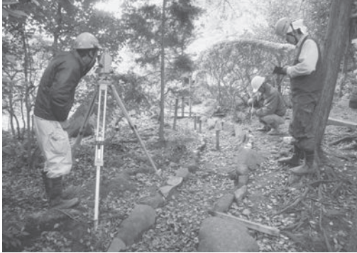
写真-23 御茶屋庭園 測量作業
