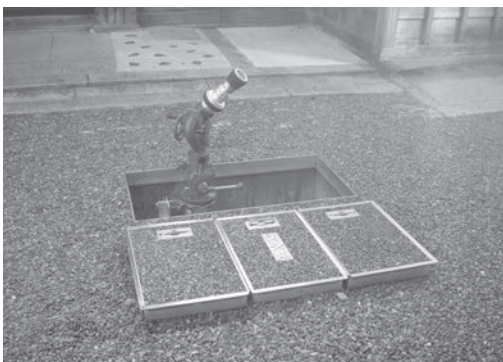
写真-27 地下式起倒放水銃
