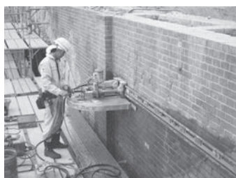
写真-6 煉瓦壁切断状況
