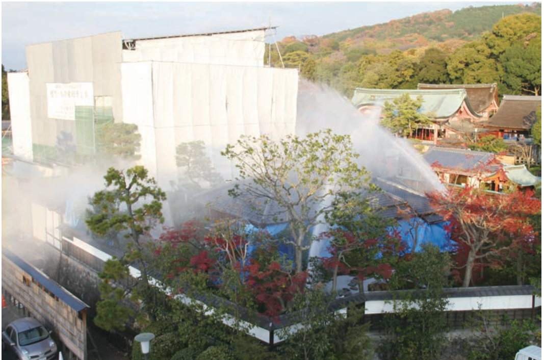
口絵4 史跡荷田春満旧宅 放水（放水銃2基とスラントドレンチャー）
