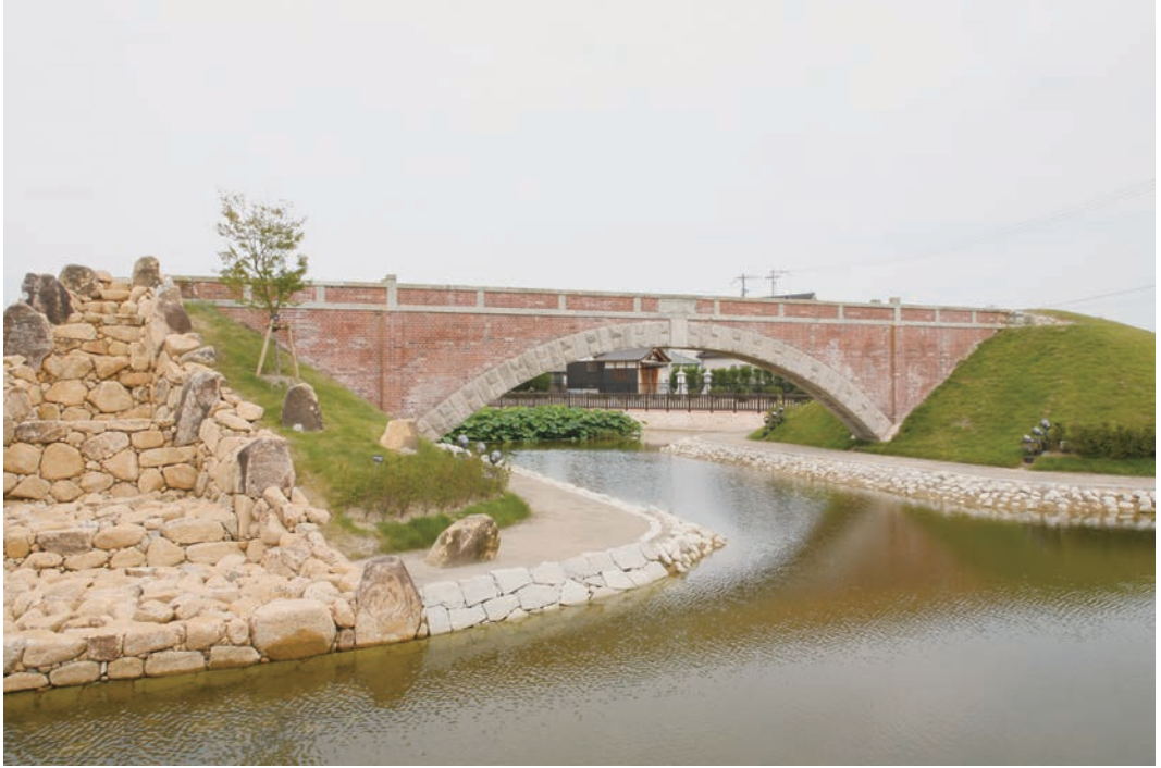
口絵1 平木橋 正面（下流側）
