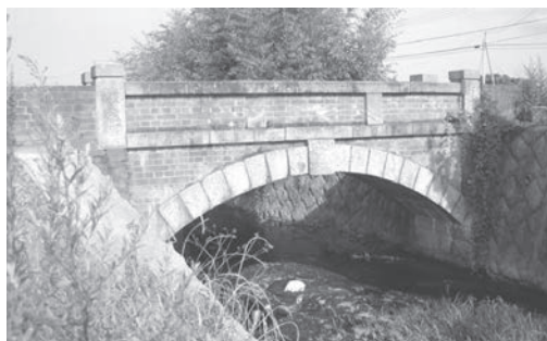
写真-17 掌中橋 (出典『平木橋保存検討委員会 報告書』)
