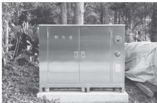
写真-13 ユニット型消火栓（外観）
