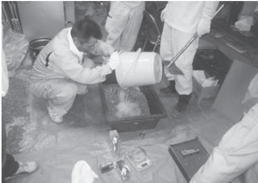
写真-25 接着剤と既存の玉砂利を混合
