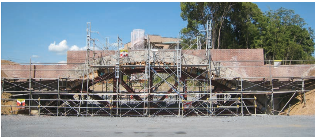
写真-5 煉瓦壁解体状況（下流側）
