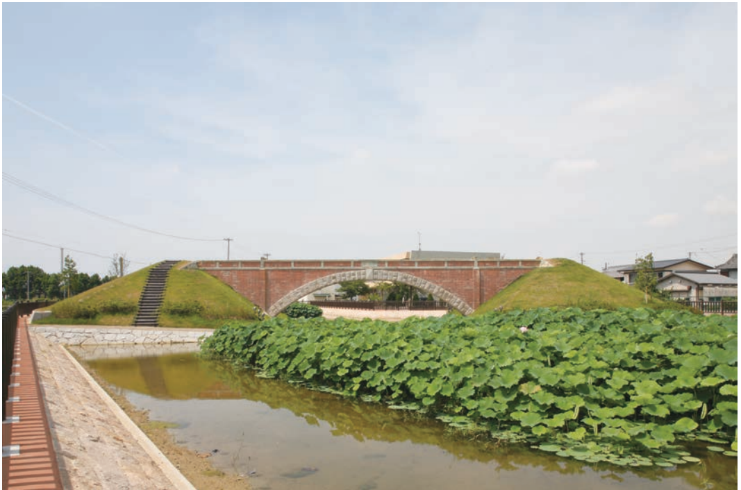
口絵2 平木橋 背面（上流側）
