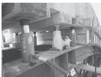
写真-7 油圧ジャッキ設置状況
