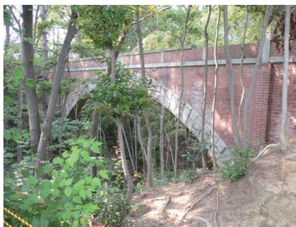
写真-1 移設前の状況（平成18年6月撮影）
