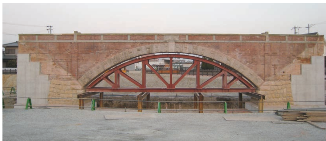
写真-11 煉瓦壁設置完了（下流側）
