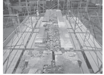
写真-14 中詰め砂利充填完了
