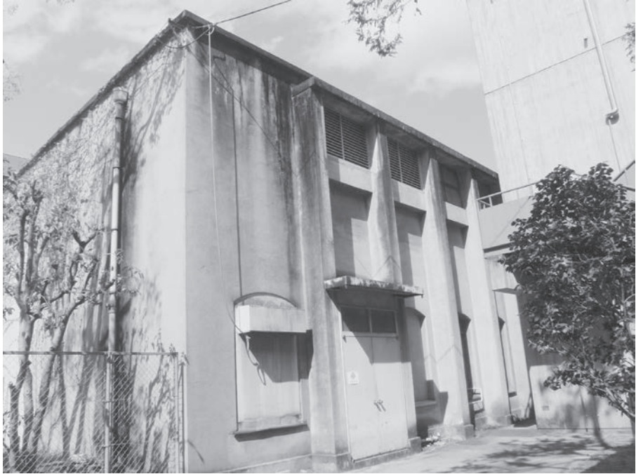
改修前南西面
