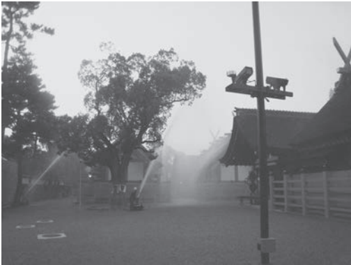
本殿透塀内での放水試験
