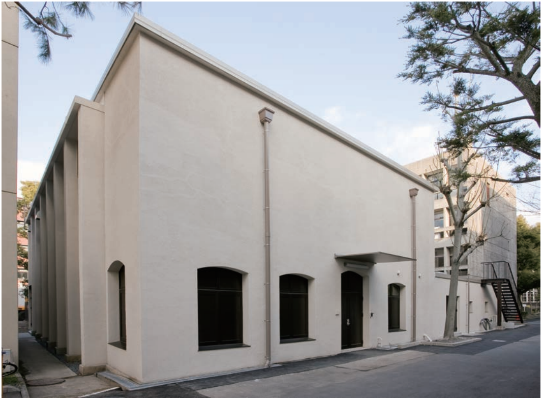
口絵 1 旧施設部変電所竣工写真
