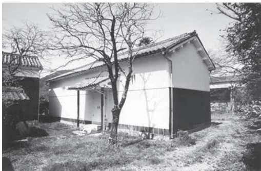
図25 米蔵（南東より） 修理前
