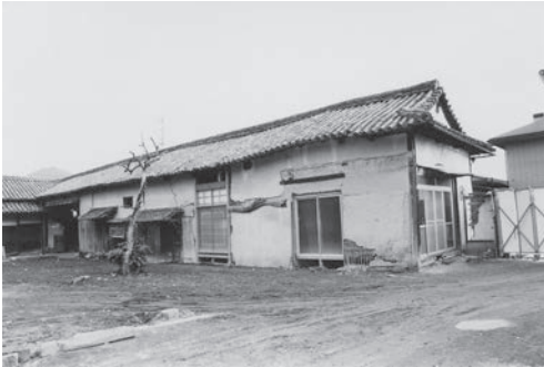
図14 長屋門（北西より） 修理前
