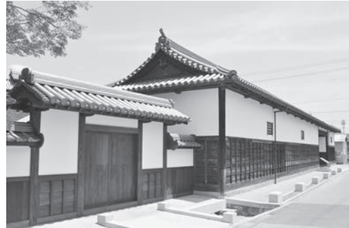
図15 長屋門及び御成門（南西より） 竣工
