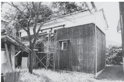
図21 内蔵（北東より）修理前
