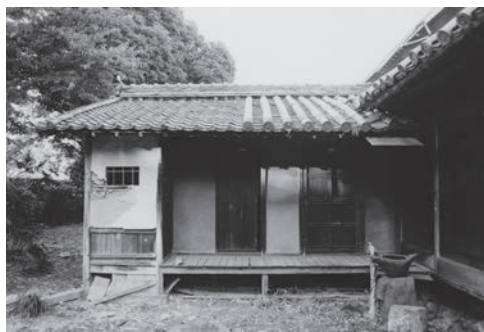
図10 西湯殿（南より） 修理前
