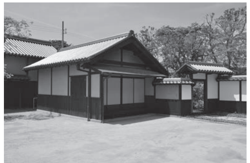
図37 便所として整備された供部屋及び中門
