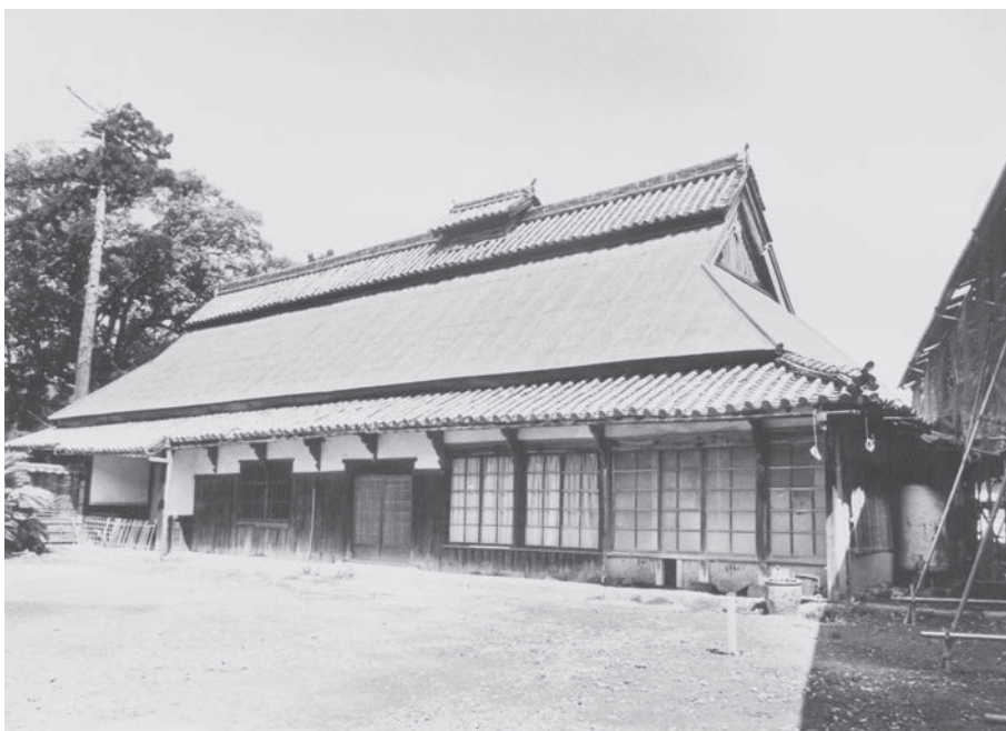
図2 主屋修理前（南東より）
