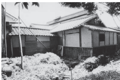
図8 離座敷及び北湯殿（北西より）修理前
