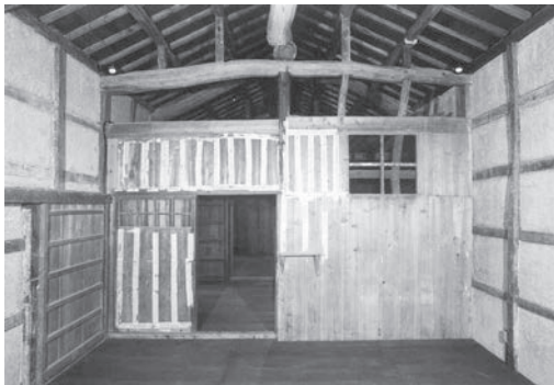
図28 米蔵 内部（東より）
