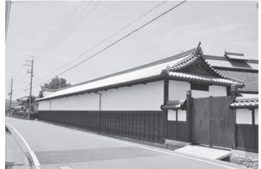
図18 同左 竣工（北東より）
