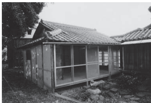
図5 離座敷（南西より）修理前
