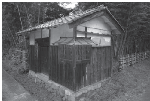
図13 修理前 乾門 正側面（北西面）
