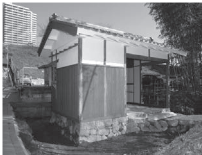
図19 竣工後 乾門 南西面
