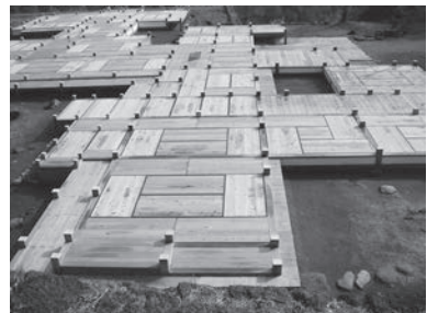
図10 床組の組立中
