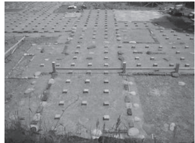
図8 礎石、束石の据付状況
