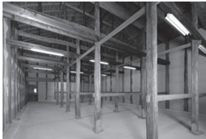
図17 竣工後 物入2 内部北西面
