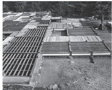
図9 床組の組立中
