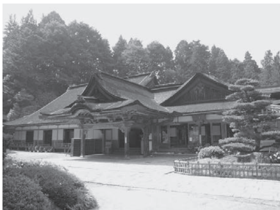
図1 金剛三昧院客殿の外観（修理前）
