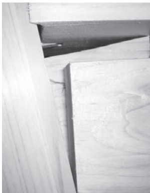
図11 足固ほぞの折損 (試験体B +1/9rad)
