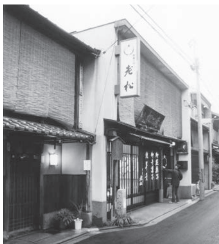
図2 改修前ファサード
