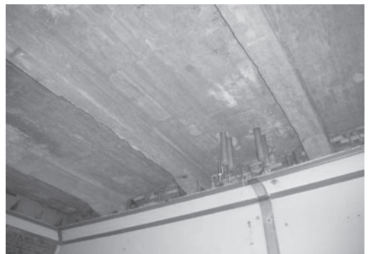
写真 3.7 鉄筋コンクリート梁 (大正12年建築部分)
