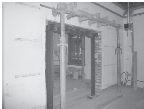
写真 2.4 建具移設のための新規開口部、鉄骨補強
