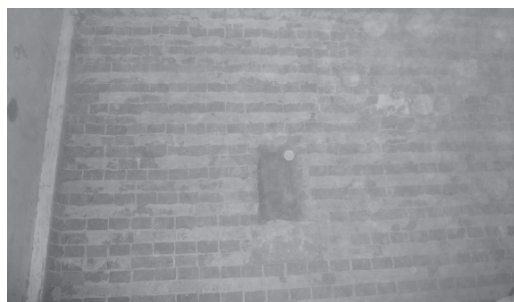
写真 3.9 階段脇壁の階段側桁受け
