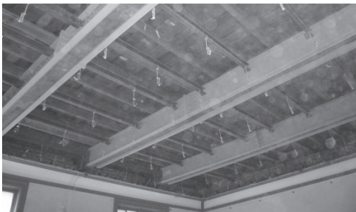
写真 3.6 昭和時代に2階床組鉄骨補強 (大正3年建築部分)
