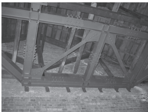
写真 4.3 鉄骨水平ブレース取付
