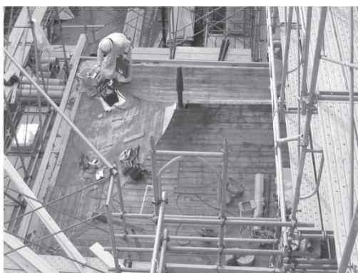
写真 2.2 玄関ポーチ銅板撤去
