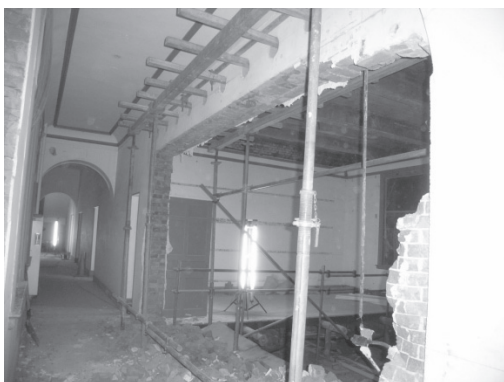
写真 2.3 便所整備、廊下間仕切開口
