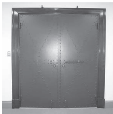
写真 3.11 同左の表面 (2階から移設)
