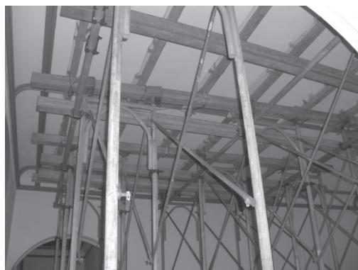
写真 2.6 中央階段、天井を下から養生のうえ、天井裏で鉄骨取付け
