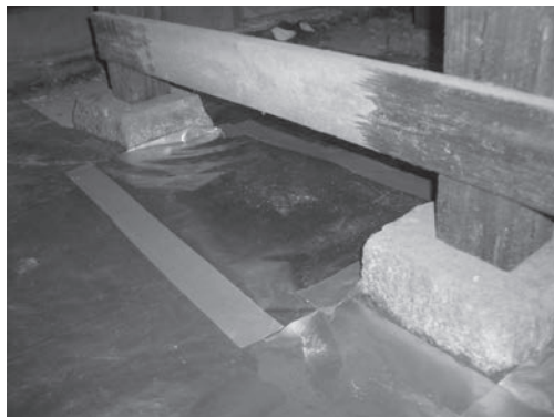
写真2 ジョイントテープ施工
