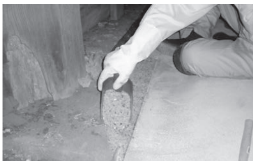
写真3 ガラス粒剤充填作業
