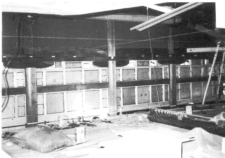
写真-2 柱間に木軸を組みステンレスパネルを挿入した
