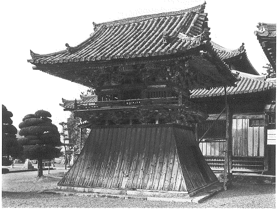
写真-2 解体前の状況（北東から見る）
