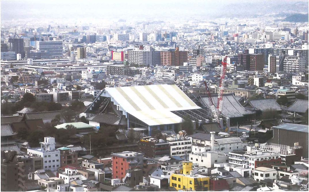
口絵3 本願寺大師堂 素屋根工事状況
