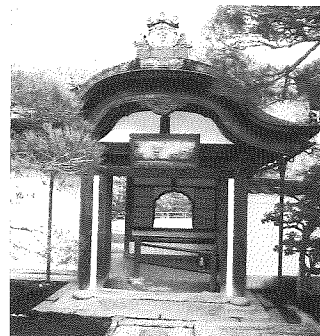
図2 修理前玄関廊正面（西より）
