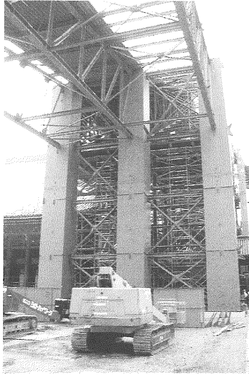
素屋根鉄骨柱
