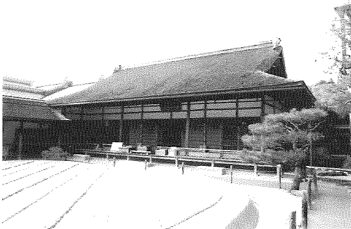
図1 修理前方丈全景（南東より）
