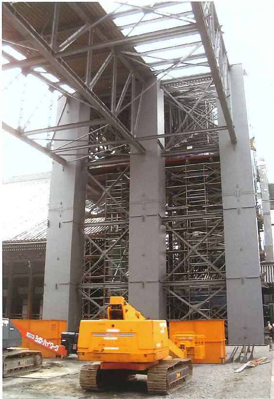
口絵4 素屋根鉄骨柱
