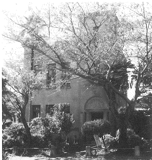
写真-1 着工前の旧図書館正面
