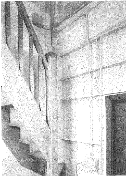
写真-4 2階塔屋内部 南西面を見る 鉄骨の構造補強材が判る
