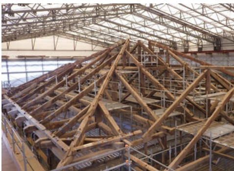
写真4 本館の小屋組（南東より見る）
