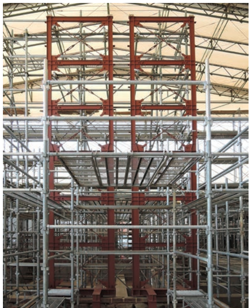
写真13 本館 鉄骨フレーム組立完了
