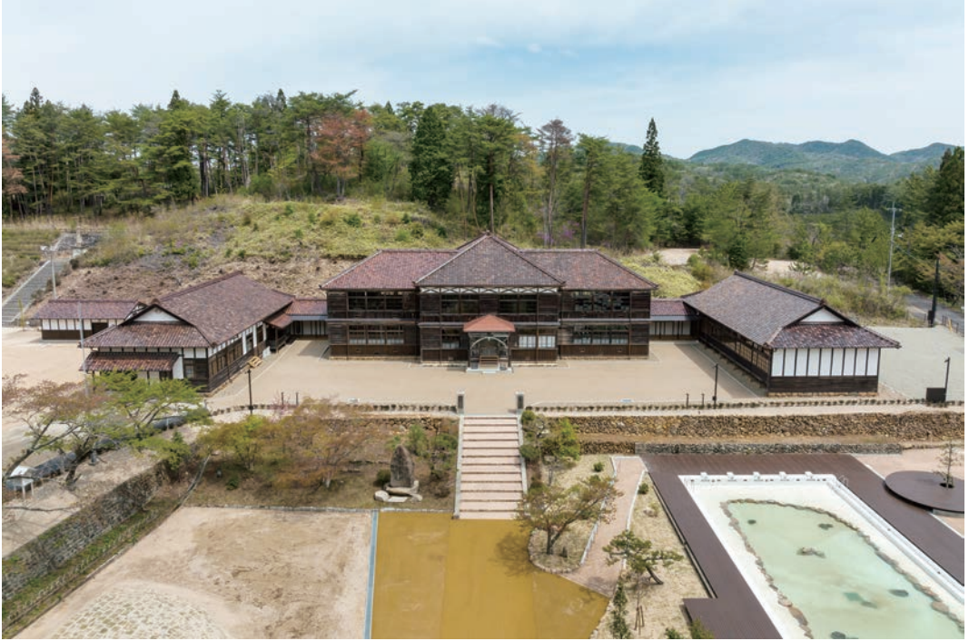
口絵 1 旧吹屋小学校校舎 全景
