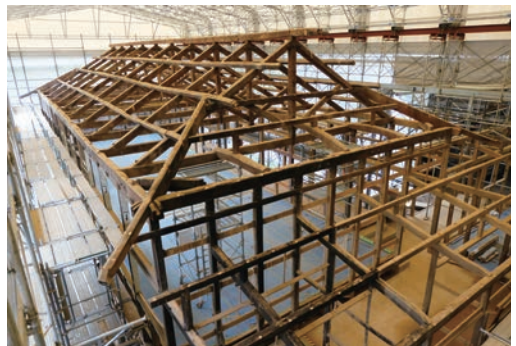
写真7 東校舎の小屋組(北東より見る)
