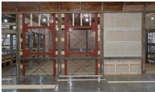
写真9 本館 乾式土壁パネルと鉄骨フレーム補強
