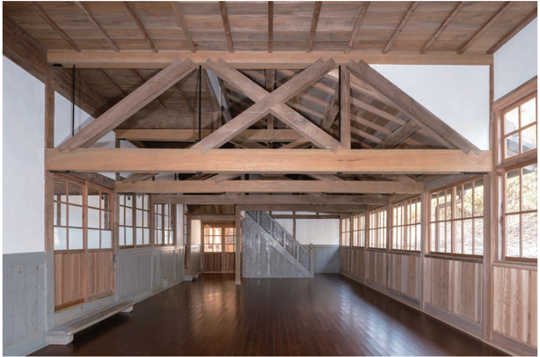
口絵 3 旧吹屋小学校校舎 本館 1階屋内運動場
