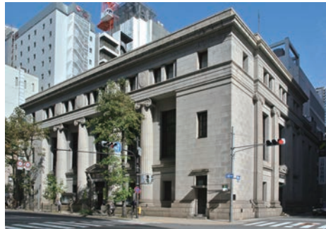
図4 旧三井銀行大阪支店（昭和11年、曾禰中條建築事務所、大阪市指定文化財）外観
