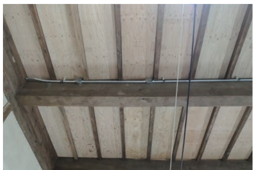
写真12 本館 2階床板下水平構面補強
