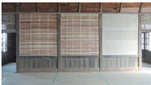
写真10 同上鉄骨フレーム壁下地取付け
