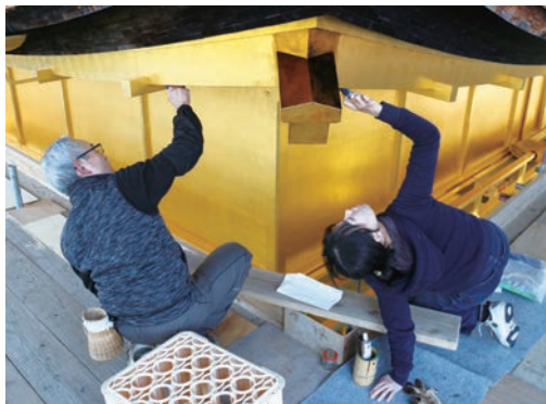
図14 軒先の金箔の修理状況
