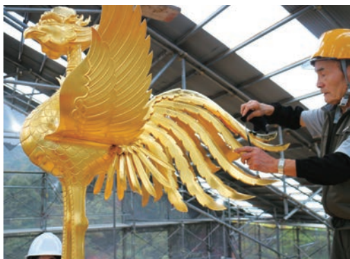
図15 鳳凰の金箔修理
