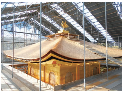
図16 屋根廻り修理完了
