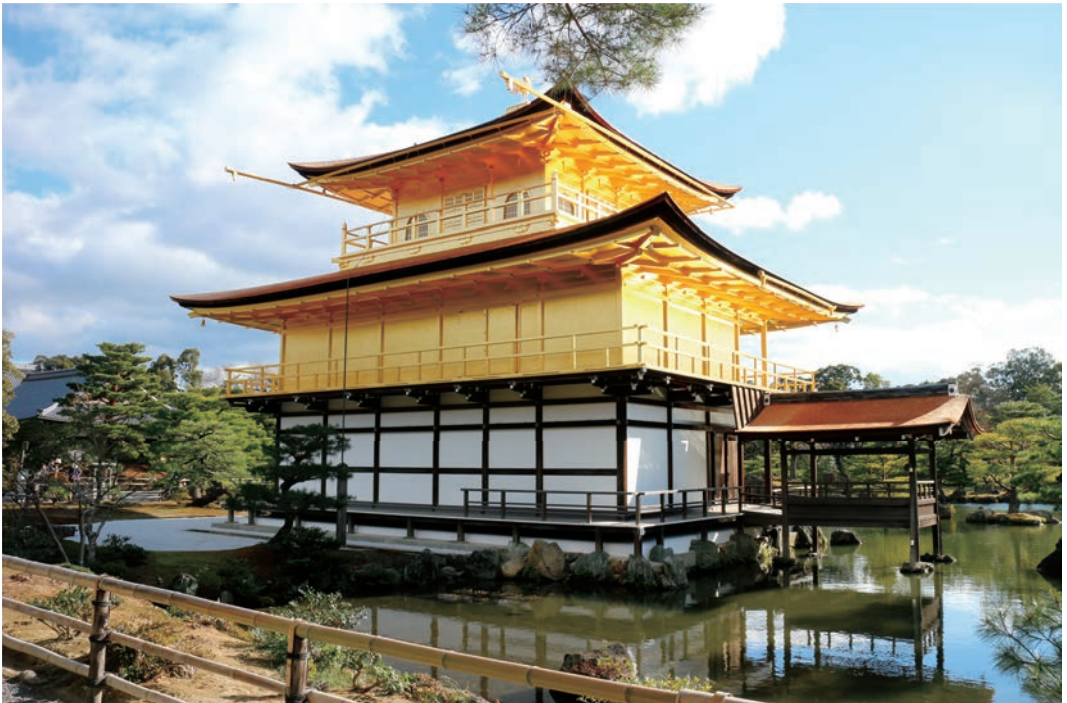
口絵2 同上 北西面を見る
