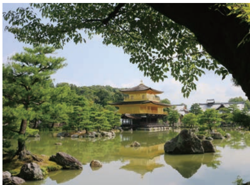
図1 修理前 西からの全景 奥に方丈庫裏が見える
