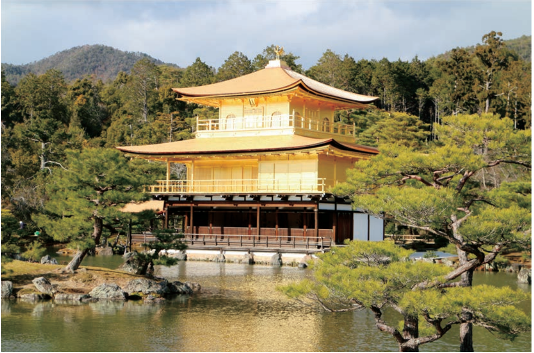
口絵1 竣工 鹿苑寺舍利殿 南東面を見る
