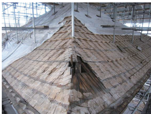
図6 屋根瓦撤去後、上層、土居葺き 雨漏り等はほとんど確認されず、土居葺き は概ね健全であった。
