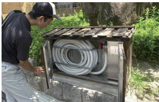
図2 一定間隔で沿道に整備された市民消火栓
