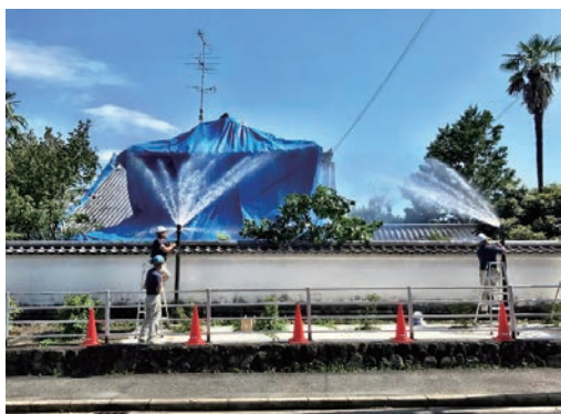
図5 妙心寺を延焼から守る WSS の試験放水
