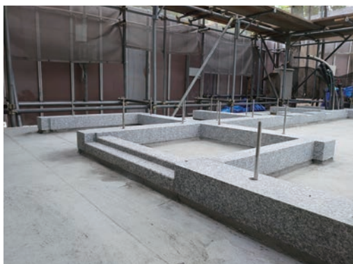
図14 監視所地覆石据付状況
