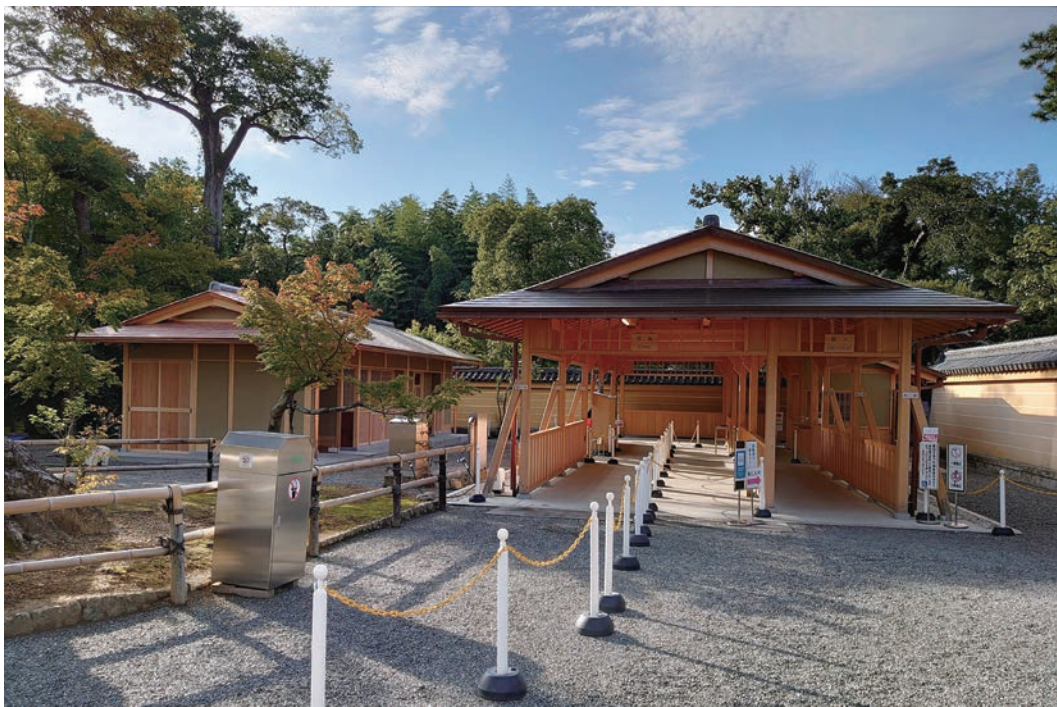
口絵2 鹿苑寺参拝通路覆屋・監視所（参道から北面を見る）
