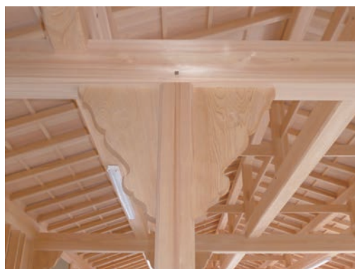
図4 覆屋柱頭部の持送
