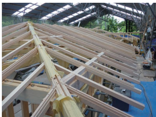
図3 覆屋小屋組の状況
