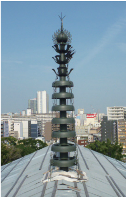
図11 相輪、修理後（再塗装）
