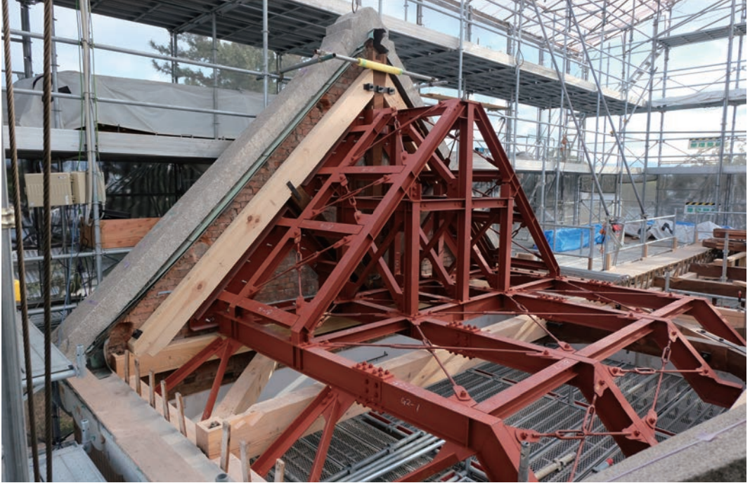
写真14 洋館 南妻壁 鉄骨補強（北東より見る）
