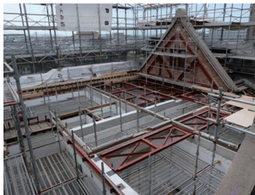
写真17 洋館 煉瓦壁上部 臥梁配筋状況
