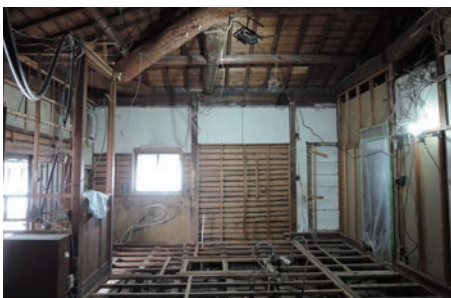
写真12 和館 1階台所・食堂仕上材解体完了 (西より見る)
