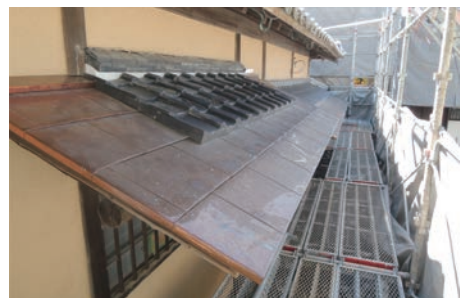
写真13 和館 東面下屋屋根完了 (南東より見る)
