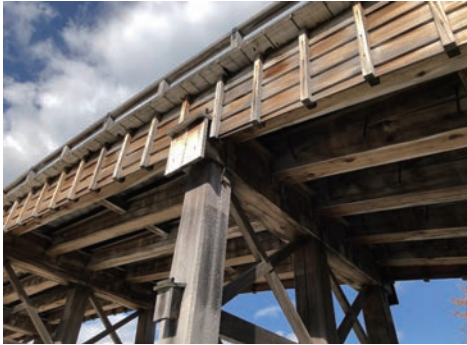
写真15-9 木製橋脚の木口を覆う板（錦帯橋）
