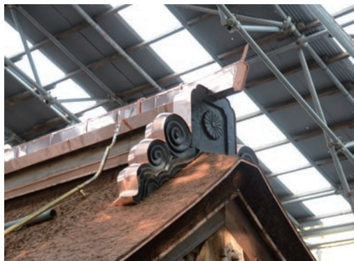
図7 竣工 鬼板新調、上端のみ銅板巻き
