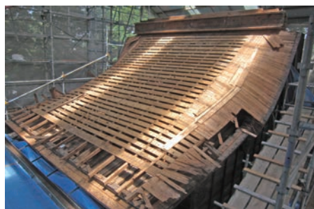
図3 屋根野地修理前
