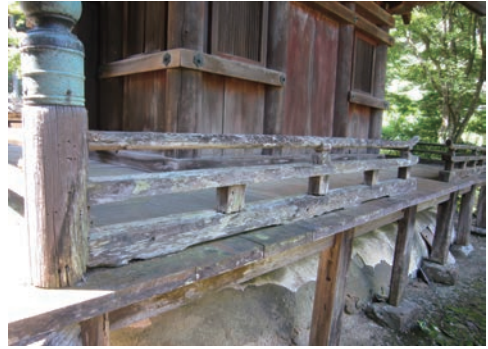
図3 修理前 初層高欄（東面）
