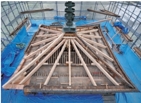
図4 3層桔木を全て取替え。 左手前野隅木は腐朽のため取替え。（南面）
