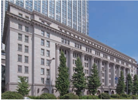
図1 明治生命館（昭和9年、設計・岡田信一郎、重要文化財）正面外観
