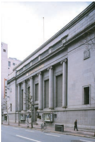
図3 旧住友銀行京都支店（昭和13年、設計・長谷部竹腰建築事務所）
