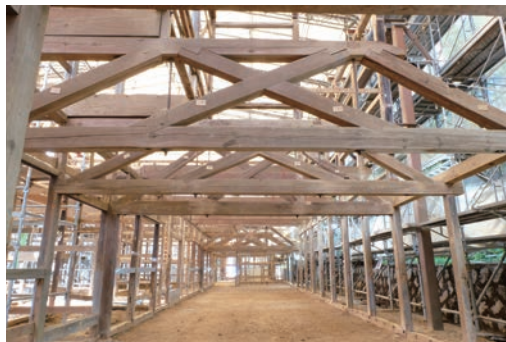
写真6 本館 屋内運動場の小屋組 (台形状の平行弦トラス)
