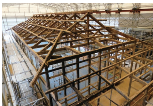
写真7 東校舎の小屋組(北東より見る)
