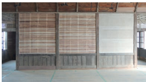
写真10 同上鉄骨フレーム壁下地取付け
