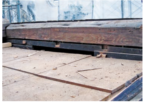
図12 内陣変更前天井 (軒桁内面に当初棹縁天井の痕跡)
