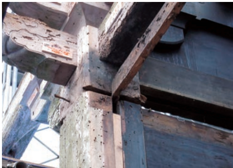
図15 外陣 変更前(板決りに埋木し、嵌め殺し菱格子を入れていた。板壁に菱格子に復旧)
