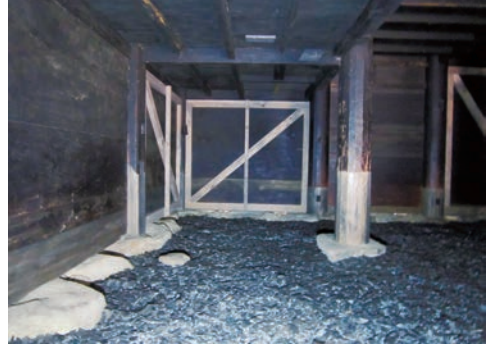
図21 構造補強 床下筋違
