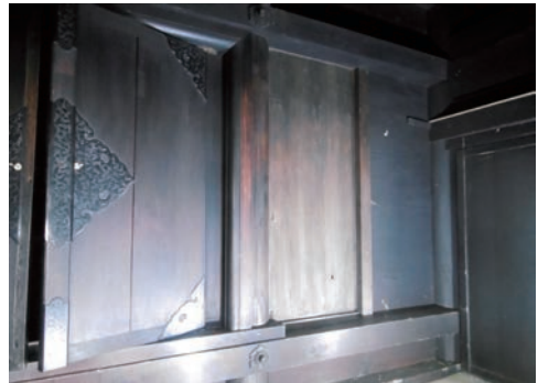
図14 内陣変更前建具(板壁に復旧)
