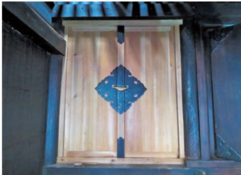
図13 内陣 変更前建具(板壁に復旧)
