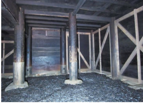
図20 構造補強 床下筋違
