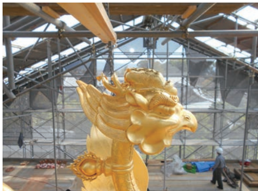
図8 鳳凰頂部 箔が捲れ下地が見える
