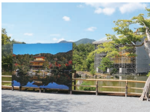
図9 素屋根足場建設中と 鹿苑寺が設置した写真パネル
