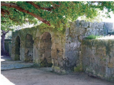
旧崇元寺第一門及び石牆（内側から）
