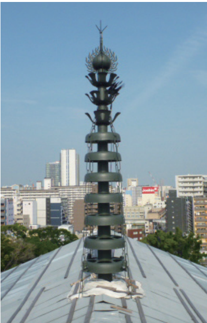
図11 相輪、修理後（再塗装）
