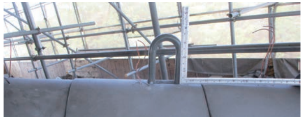
図13 宝珠止め金具、修理後 切断部分から先を溶接した。
