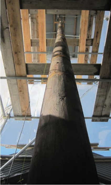
図9 真柱、相輪部分、金物撤去後。 東に傾斜している。
