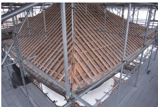
図7 瓦棧施工状況、上層 空葺き用の縦棧取付け後。
