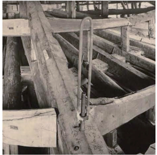
図15 昭和11年、工事写真 宝珠止め金具修理後
