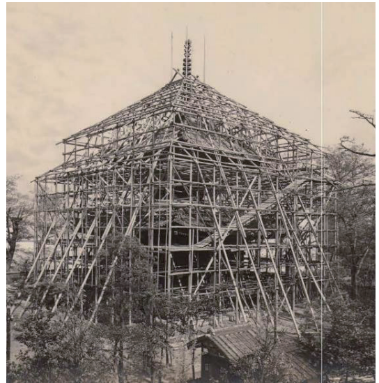
図17 昭和11年、工事写真 丸太組の素屋根
