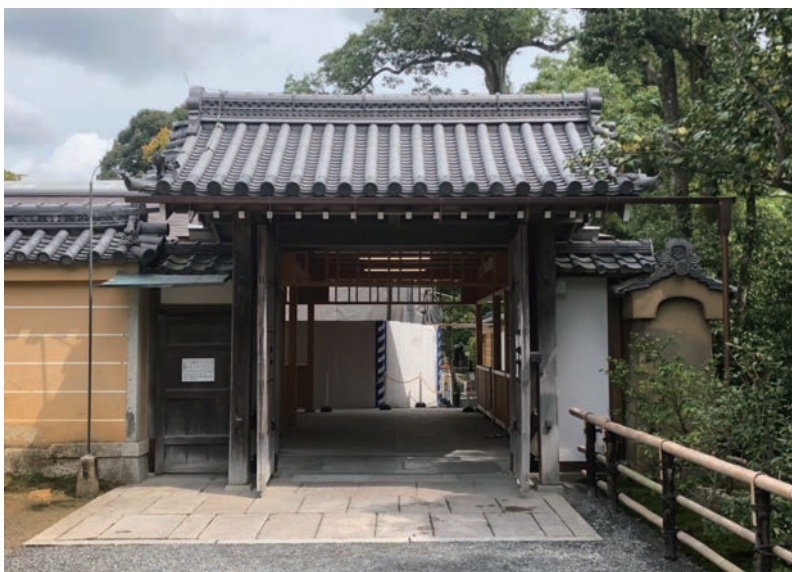
図5 参拝門西面全景（修理後）
