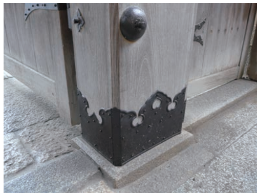
図7 参拝門親柱の根巻金物
