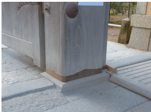
図6 参拝門親柱の根継ぎ
