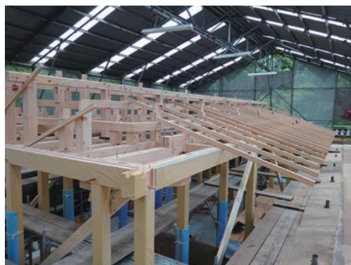
図15 監視所小屋組の状況
