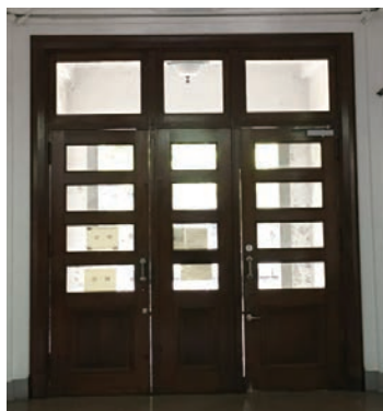
図9 正面玄関出入口扉
