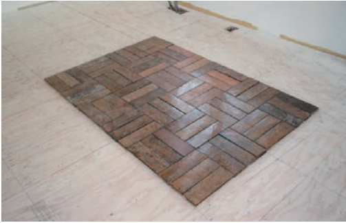
図3 床パーケットタイル貼（2階）
