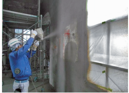
図2 躯体中性化補修表面被覆吹付状況（2階廊下）
