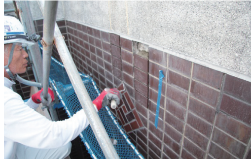
図4 外壁補修（タイル復旧状況）
