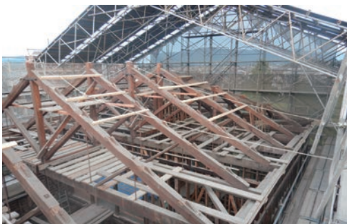
写真7 修理前小屋組トラス
