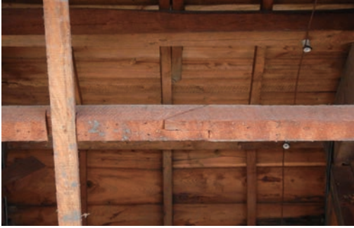
写真19 天井野縁下面 木摺り板痕跡
