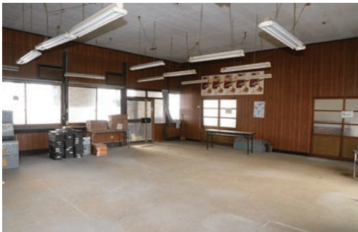
写真3 修理前ショップ（中央）（東北側を見る）
