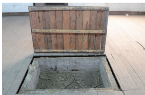
写真22 修理前ショップ床板煉瓦区画部分
