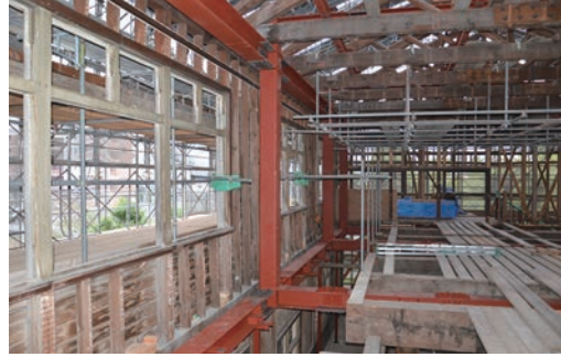
写真10 鉄骨フレーム
