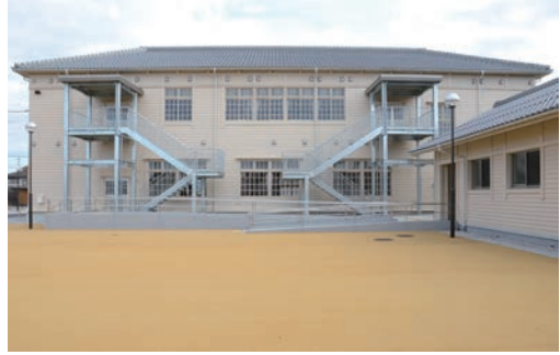
写真24 竣工背面（南面）
