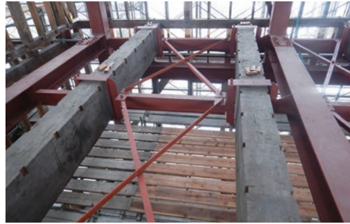
写真12 2階床下水平ブレース
