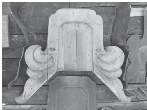
図14 鬼板、銅板包み解体状況（表面）、背面に修理年記載
