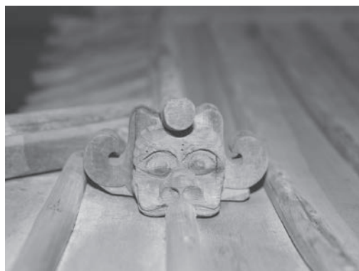
図13 宮殿、修理後 降り棟鬼板、再取付け
