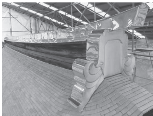
図11 箱棟補修完了
