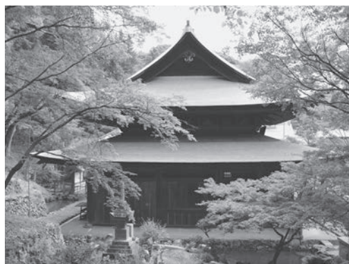
図15 施工完了、西面外観
