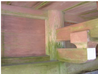
写真4-3 藻類に汚染された建築物の部材
