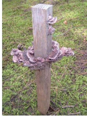
写真3-2 土中に埋められていたスギ杭から発生した子実体（腐朽はかなり進行していることを示す）
