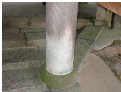
写真4-1 石との接触部からの柱の白化現象
