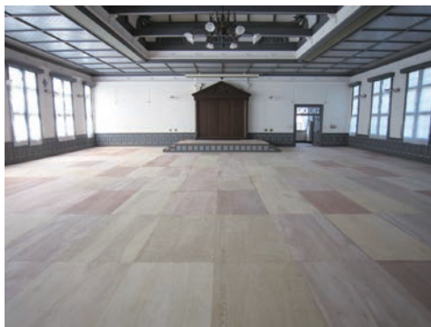
図3.2 2階床構造用合板の設置
