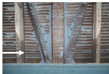
図3.10 筋違端部金具
