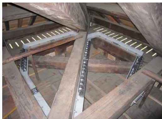
図3.6 小屋裏、鋼製筋違の設置
