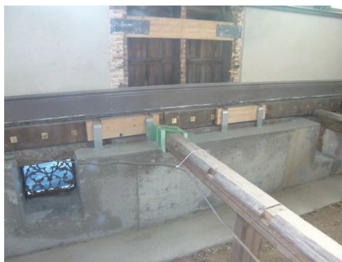
図3.5 基礎梁、付土台の設置
