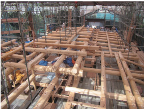
図19 方丈・書院棟小屋組の状況
