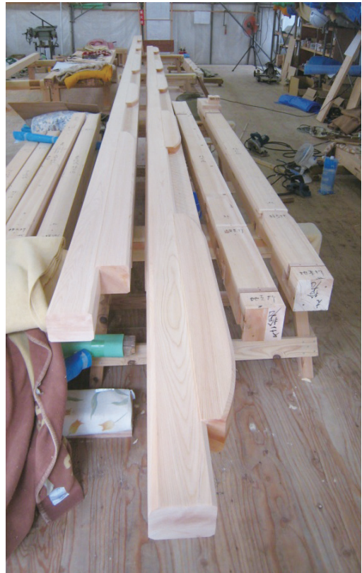
図20 茶室棟軒桁の加工状況
