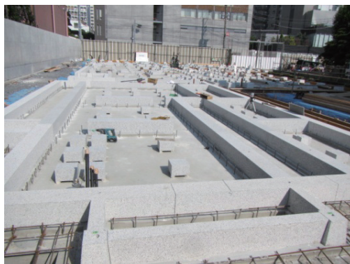
図14 茶室棟柱礎石据付状況展開図
