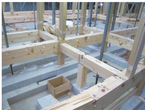
図15 茶室棟足固取付状況
