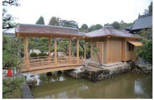
図7 天池堂・渡り廊下（南西より見る）
