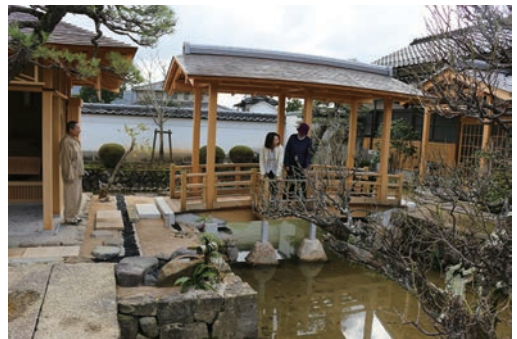
図11 渡り廊下（北より見る）
