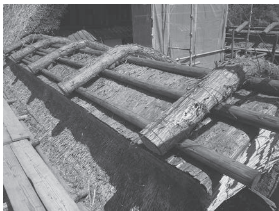
図5 棟廻り葺き替え完了
