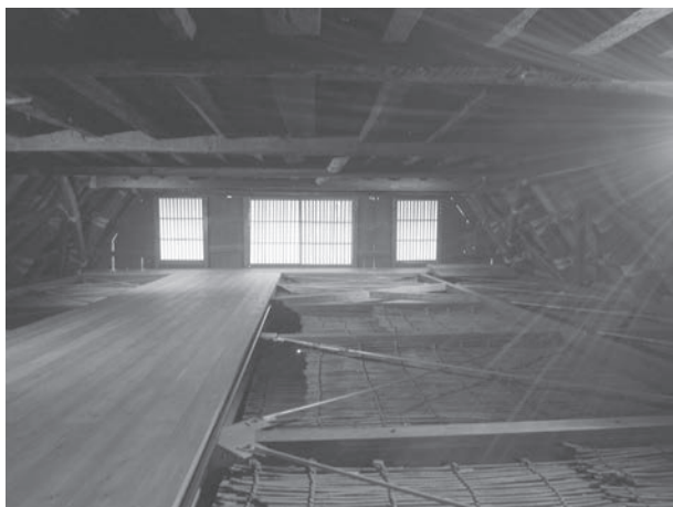
図13 水平ブレース、床板張り完了
