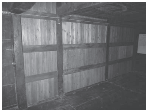
図10 複合鋼板パネル、化粧板張完了
