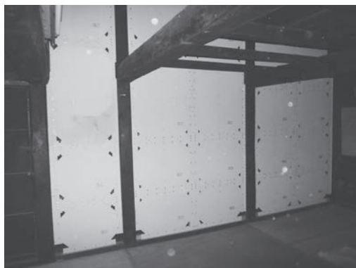
図9 複合鋼板パネル取付け状況
