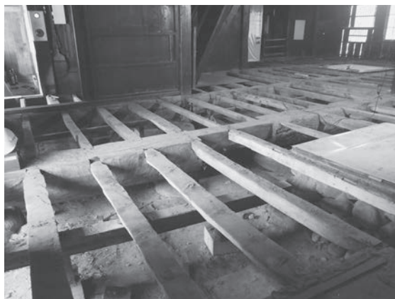
図4 床板解体完了
